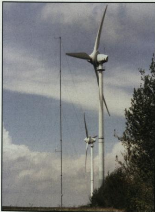
Abb. 6: Ein Windmessmast birgt im WP bei Wittmannsdorf eine zusätzliche Kollisionsgefahr. 27.4.2003. Foto: R. Möckel.
