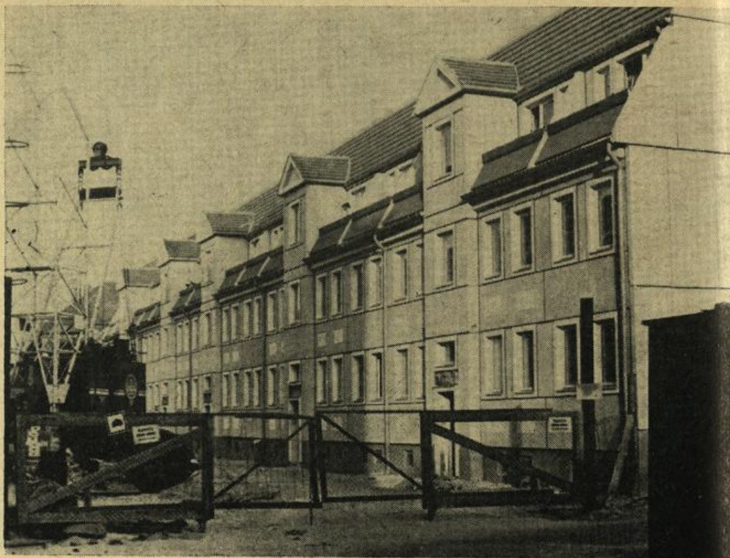
Um das architektonische Gepräge der Stadt zu erhalten, werden die notwendigen Ersatzbauten in der Innenstadt in Anlehnung an die barocken Bürgerhäuser errichtet. Der Experimentalblock in der Gutenbergstraße (Aufnahme April 1984)
