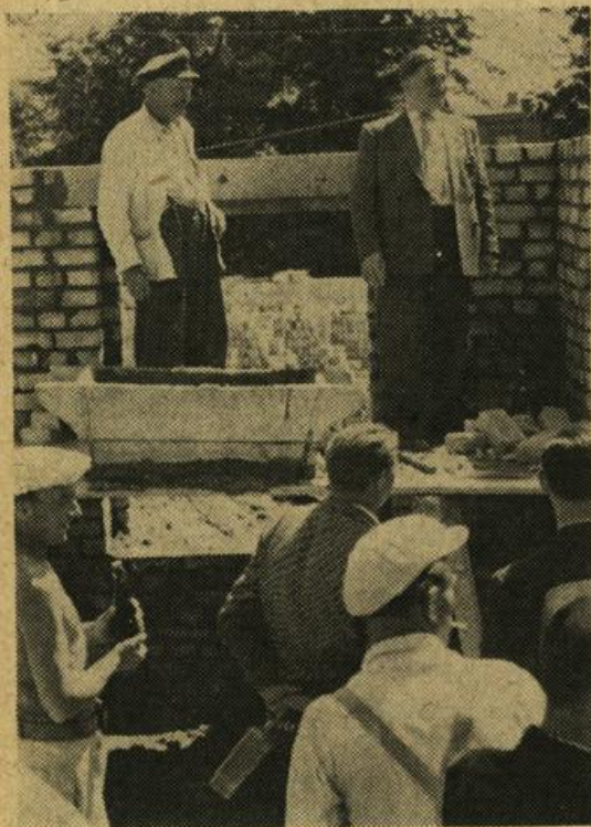
Oberbürgermeister Max Herm bei der Grundsteinlegung für das Hochhaus in der Friedensstraße am 6. Juni 1959. Stadtarchiv Brandenburg
