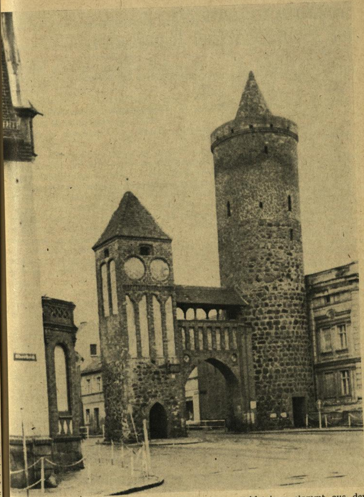
Das Zinnaer Tor in Jüterbog. Der Unterbau aus Feldsteinen stammt aus dem 14. Jahrhundert, der obere Teil aus Backsteinen wurde erst 1480/90 fertiggestellt. In ähnlicher Form hat Thomas Müntzer dieses Tor gesehen. Foto: Brehmer
