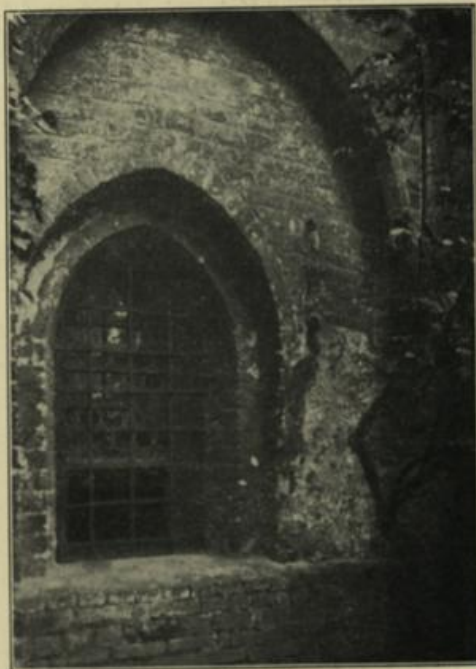
d. Kryptafenster mit romanischem Mauerrest rechts.
