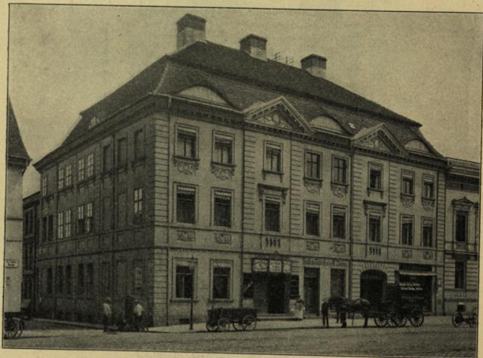
Abb. 129. Haus Bieten, St. Annenstraße 12.
