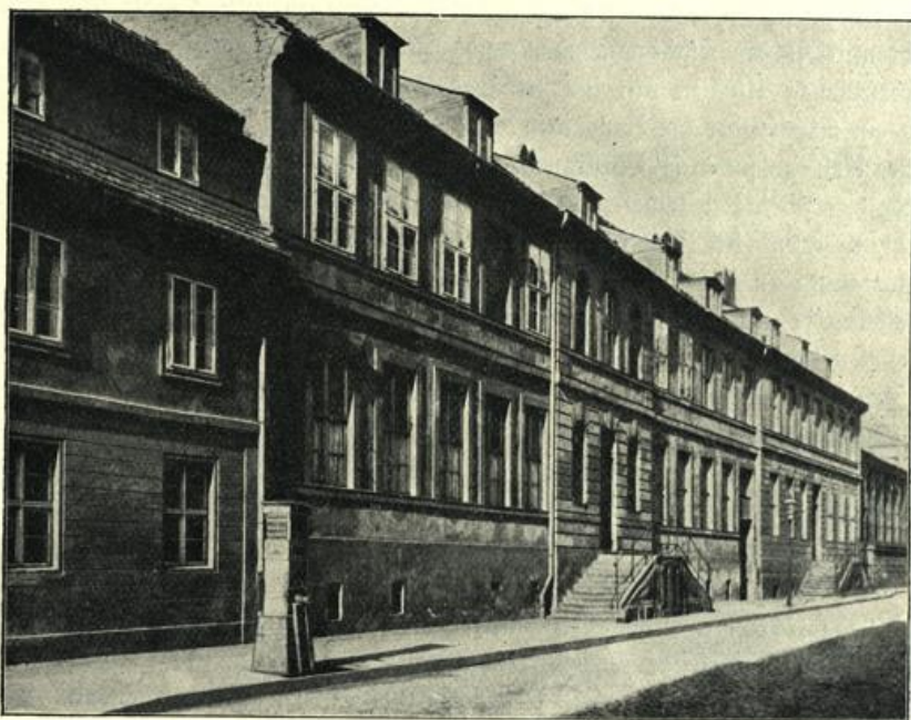
Abb. 33. Sogenanntes französisches Rathhaus auf dem Werder. Aufnahme von Hofphotograph F. Alb. Schwarz-Berlin.
