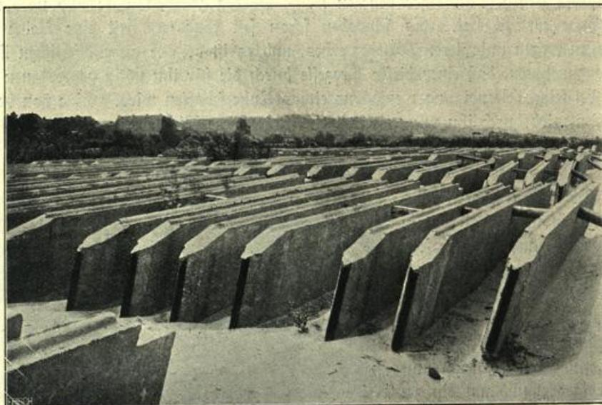
Abb. 58. Hafenanlage Spandau, Lager fertiger Beton-Spundbohlen.
