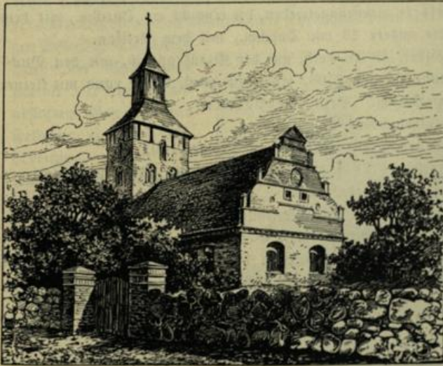
Abb. 313. Sonnenberg. Kirche von Südosten.
