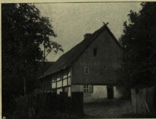
Abb. 78. Herzberg. Haus Kùgow, Ansicht von der Straße.
