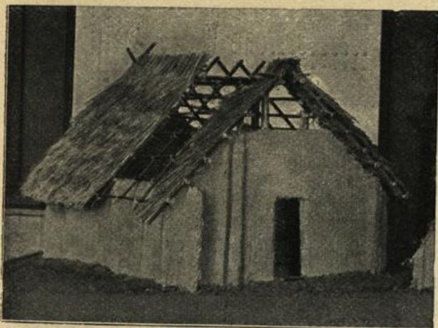
Abb. 34. Bronzezeitliches Haus von Buch. (Nach beobachteten Resten und Spuren wieder auf- gebaut.)
