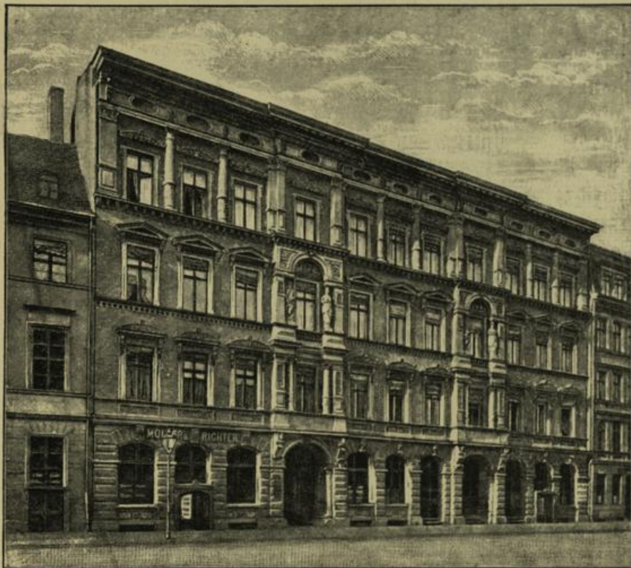
Der Neubau in der Klosterstraße 45.
