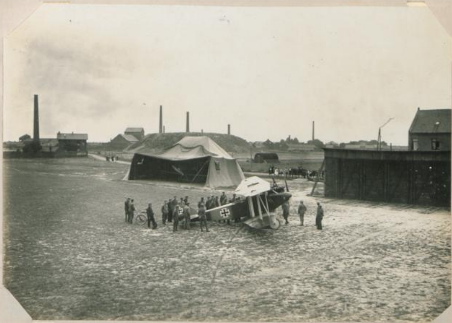
Eintreffen der neuen Ago-Maschine
