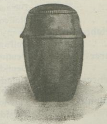
Meisterstück eines Kupferschmieds. Urne aus Kupferblech von Hand getrieben, nach selbstangefertigtem Entwurf mit Kosten- berechnung.
