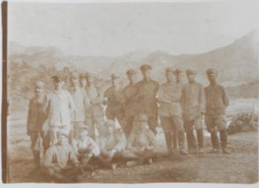
Auf der Bahnstation Bosanti im Taurus. 13. 9. 17.
