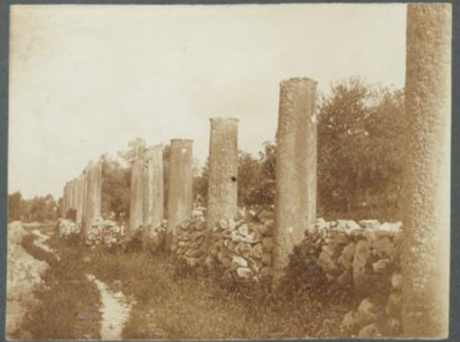
Steinmauer der Grenzbau bei Meosdige.
