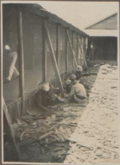
Decken der Schindeldächer
