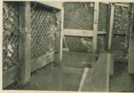
Stechwasser im Laufgraben.
