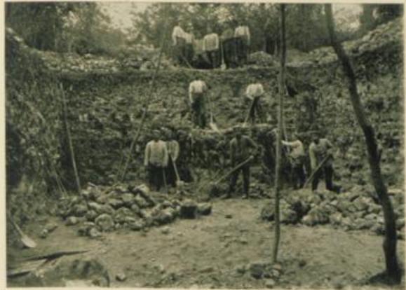
Baugrube für Unterstand.
