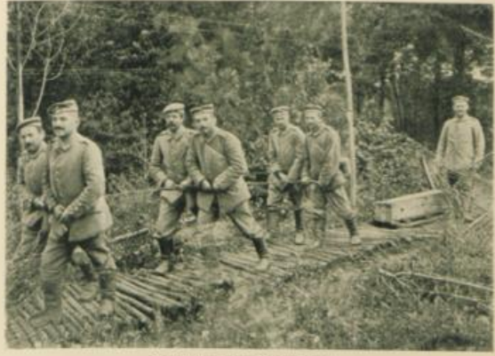
Transport von Betonblöcken.
