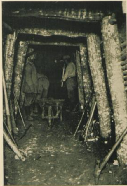
Minierter Unterstand im Bau.
