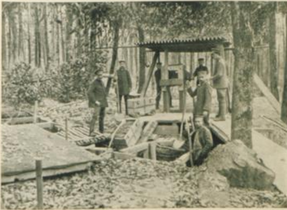
Erdbefestigung aus acht Meter Tiefe.
