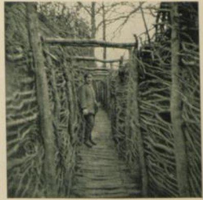
Graben im Bau.
