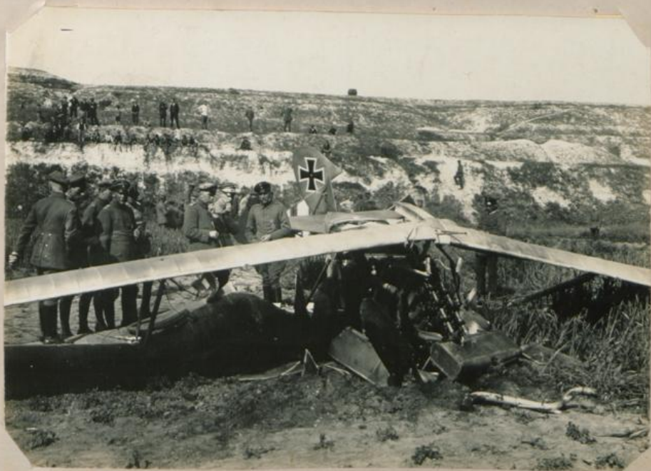
Absturz mit restlosem Bruch
