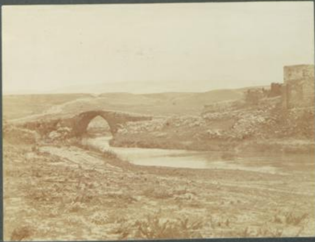
Jordanbrücke über den Jordan zwischen Jala und dem Berg.
