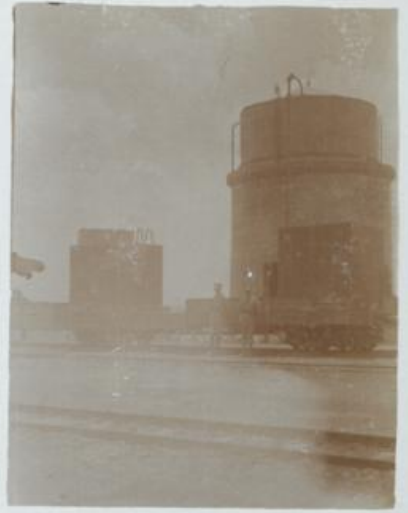
Wasserkraftwerk des Sueskanals bei Suez.
