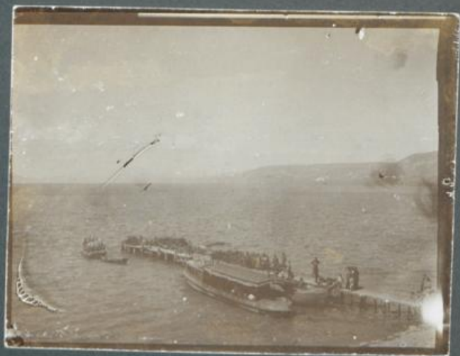
Landungsbrücke am Van Gungwallf bei Sammach
