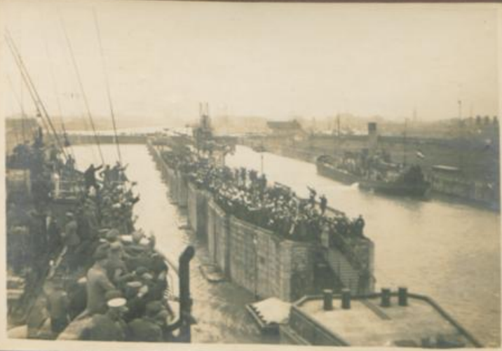
vor und in der Schleuse
