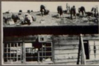
Decken der Schindeldächer
