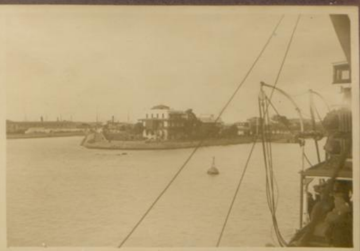
Einfahrt in den Kanal
