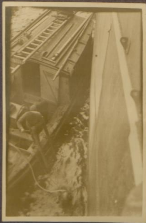
-Taucher untersucht den Schiffsboden vor der Einfahrt in den Kanal
