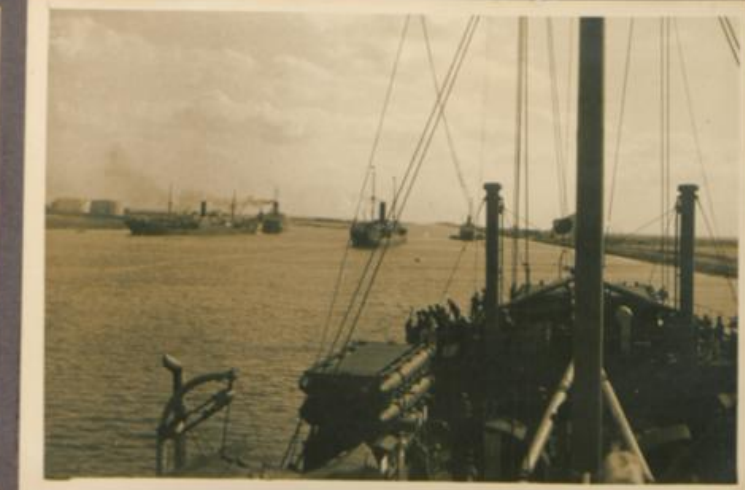
Einfahrt in den Kanal
