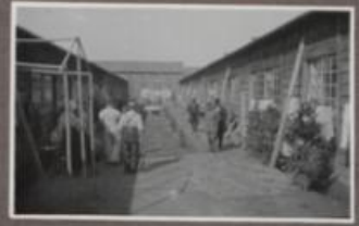
Luckenanlage zwischen den Baracken
