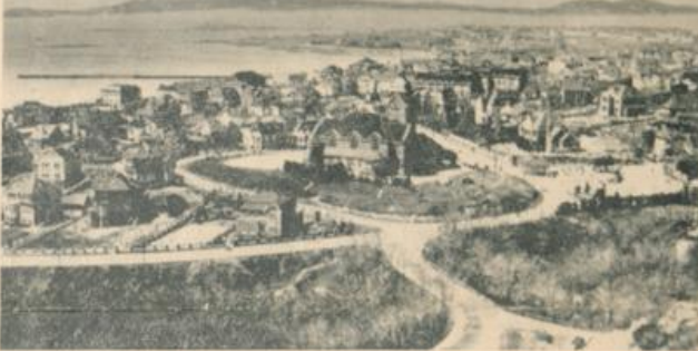
Das ist die schöne Stadt Tsingtau. Der Blick geht über die Christuskirche im Vordergrund bis zur Hafeneinfahrt. Im Hintergrund ist das Perlegebirge zu erkennen.
