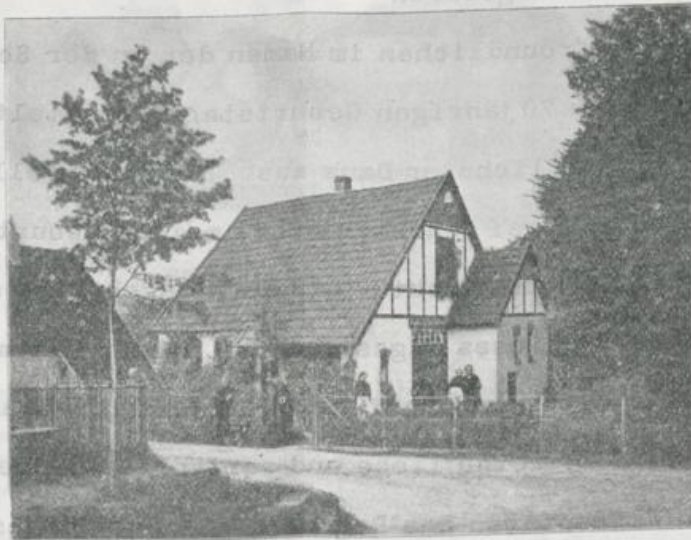
Einfamilienhaus des Vereins Arbeiterheim. Baukosten, bezugsfertig, 1906: 3733,71 Mark; 1913: 4164,79 Mark.
