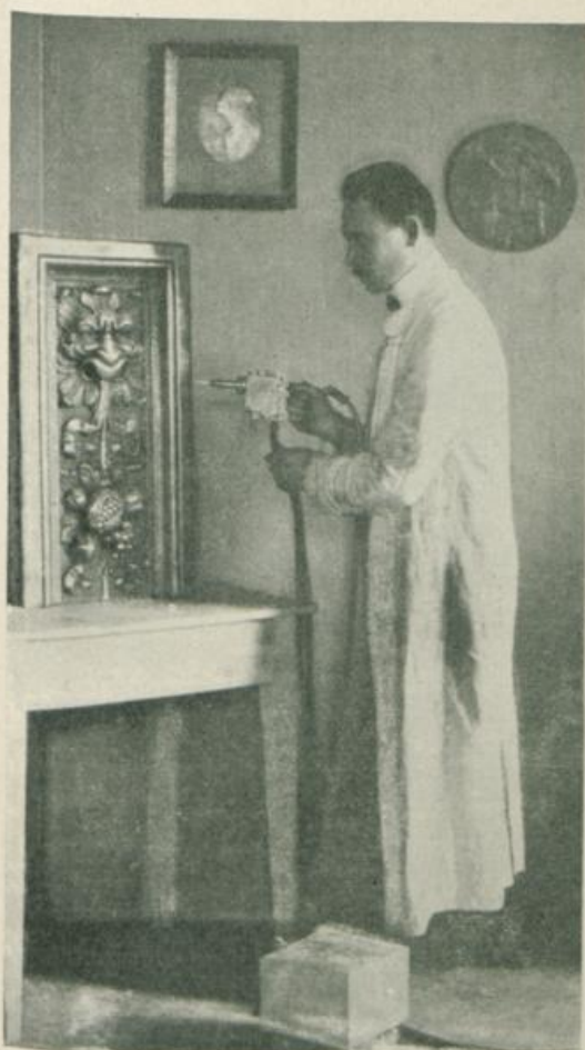
Metallspritzapparat in Tätigkeit.
