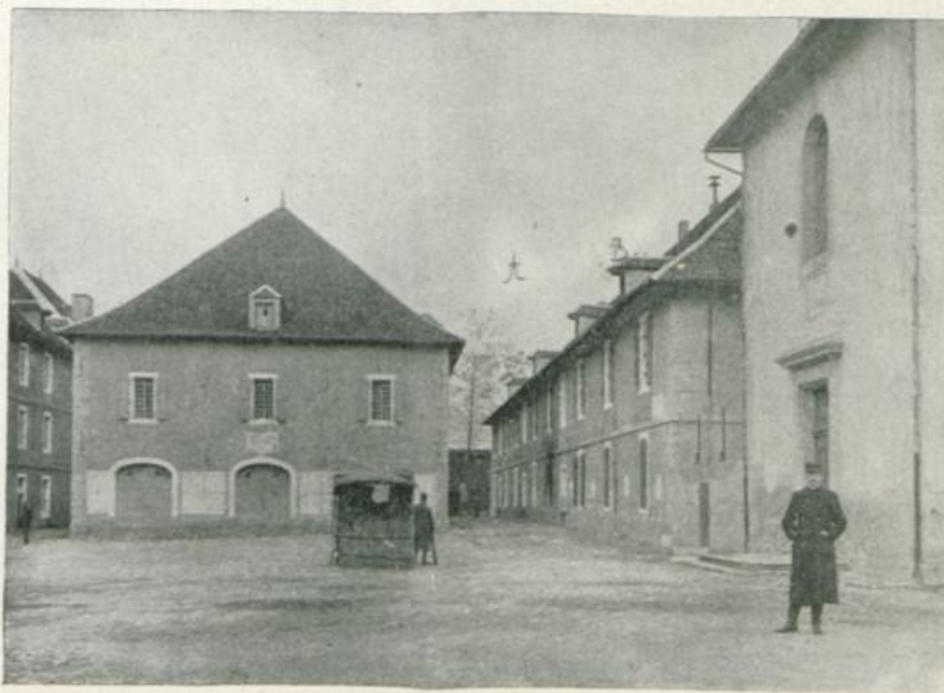
Fort Barraux, Unterkunftshaus A und B.
