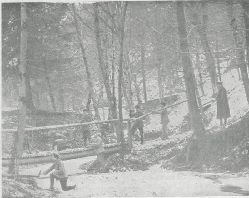
Nr. 2. Beim Wege- und Brückenbau.
