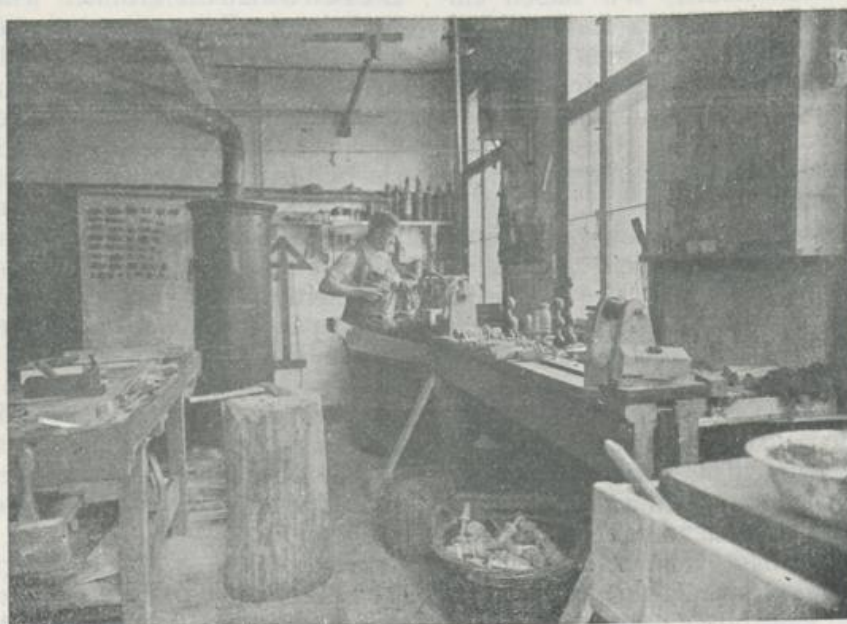
Drechserei der Tischlereiwerkstätte deutscher Internierter in St. Gallen-Heiligkreuz.
