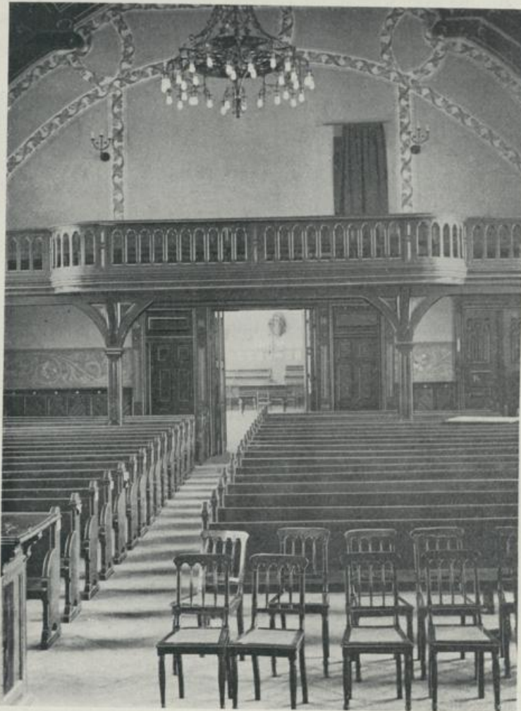
Aula nach dem Umbau mit Galerie und Durchblick in den Gesangssaal.
