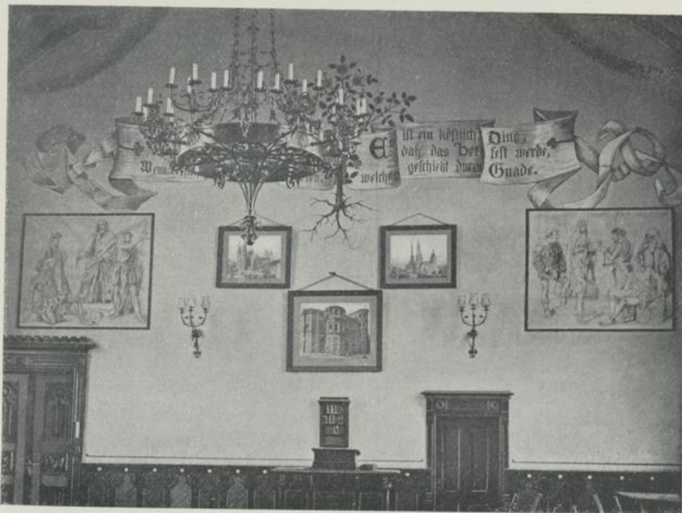
Stirnwand der Aula vor dem Umbau.
