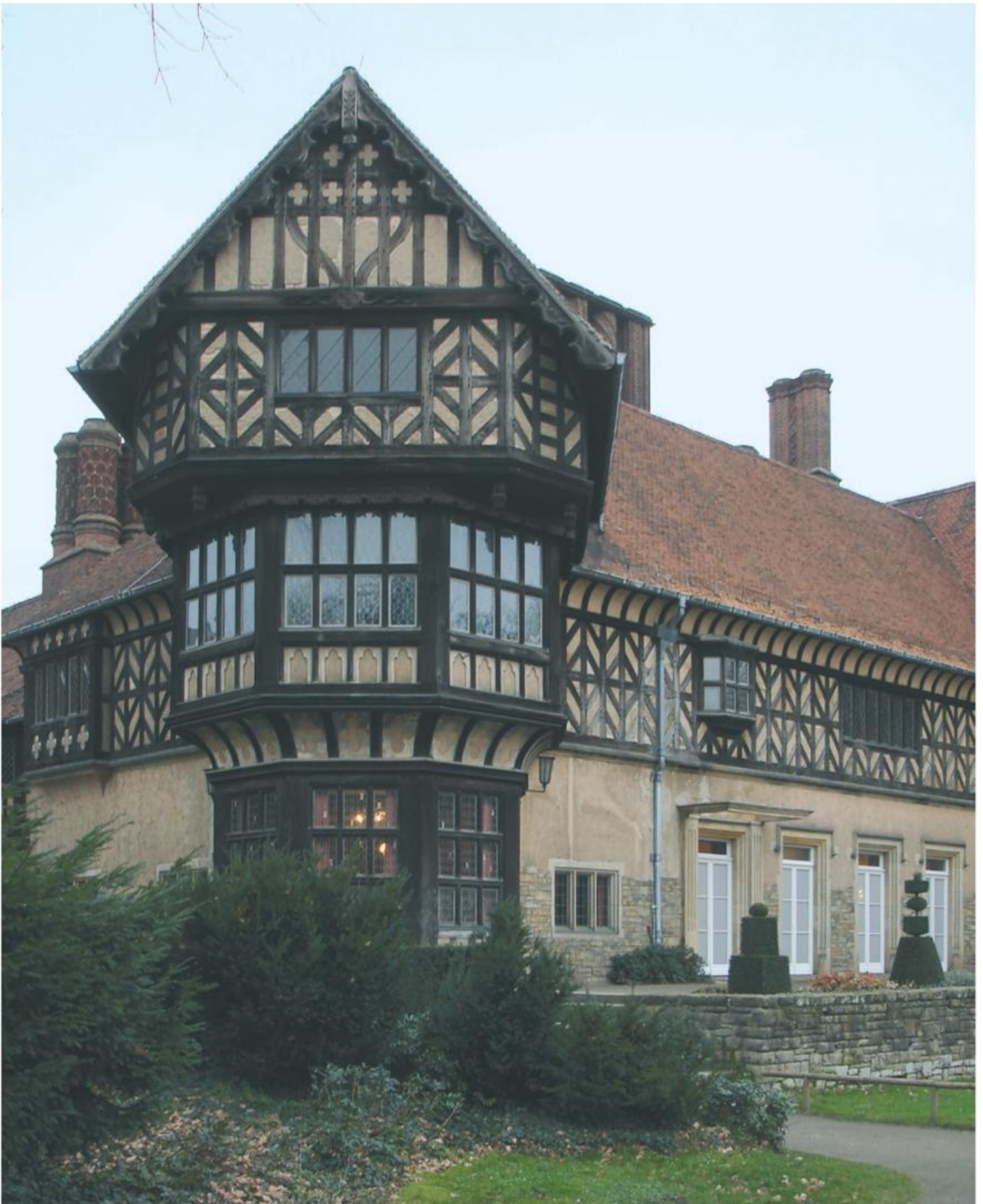
Potsdam, Schloss Cecilienhof, 1913–17. Gebaut nach Plänen von Paul Schultze-Naumburg für Kronprinz Wilhelm. Der letzte Schlossbau der Hohenzollern eine vielgestaltige Anlage aus Ziegelbauten mit Naturstein- und Fachwerkverblendung im englischen Cottagestil.
