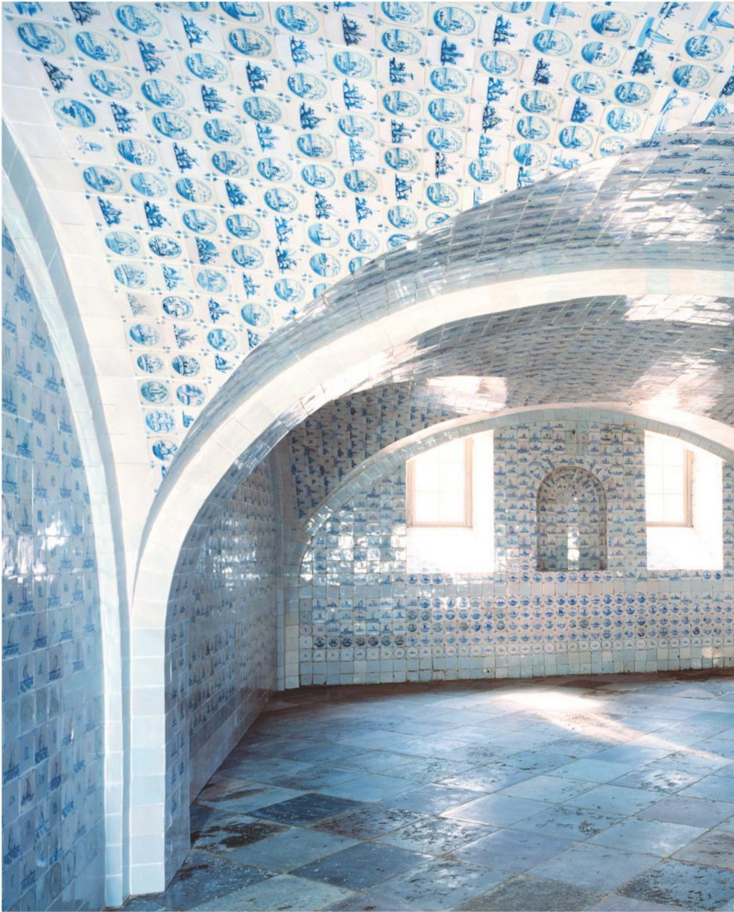
Caputh (PM), Schloss, Sommerspeisesaal. Der kreuzkappengewölbte Raum wurde um 1720 für Friedrich Wilhelm I. vollständig mit holländischen Fayence-Fliesen verkleidet – eine hinreißende, in Deutschland sehr seltene Raumgestaltung der Barockzeit.
