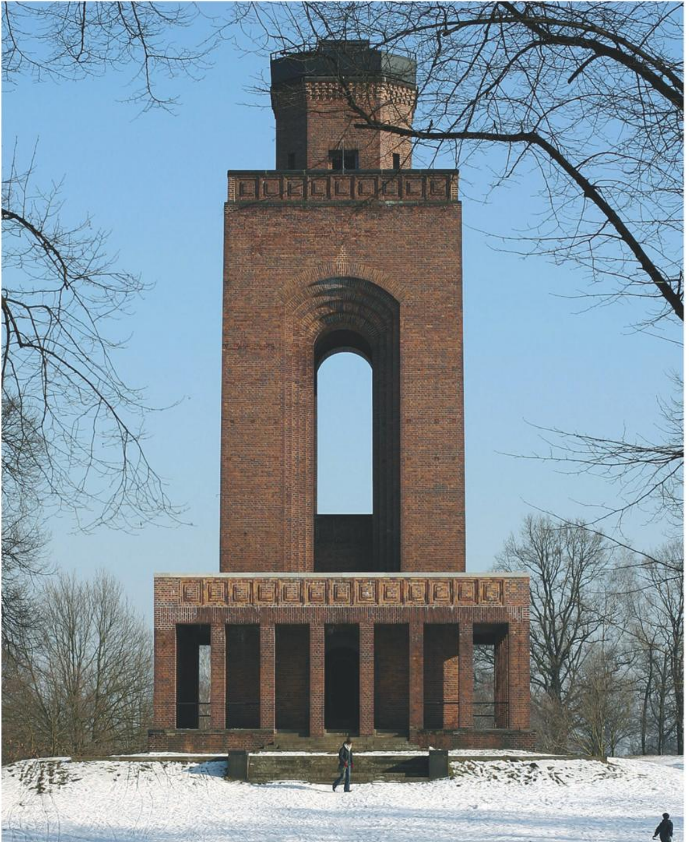
Burg/Spreewald (Borkowy/Blota; SPN), Bismarckturm, 1913–15 nach Entwurf von Bruno Möhring auf dem als Bodendenkmal geschützten Schlossberg errichtet. Ziegelsichtiger Aussichtsturm mit Feuerschale und zugleich Denkmal für die Gefallenen des Ersten Weltkrieges.
