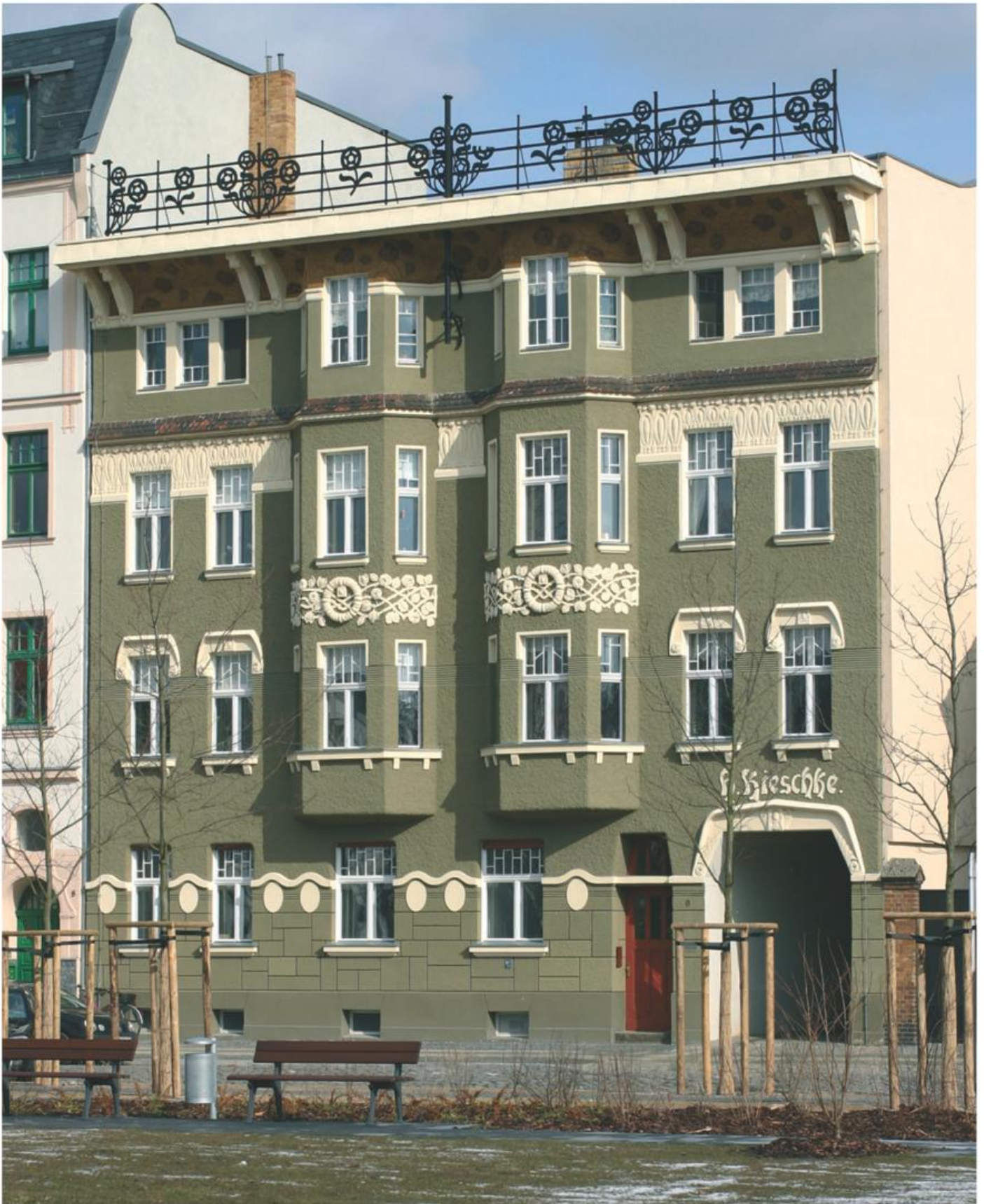
Cottbus (Chósebuz), Wernerstraße 9, Mietwohnhaus, 1905/06 nach Entwurf des Cottbuser Architektur- und Baugeschäfts Dümpert & Hauke im Auftrag des Schmiedemeisters Hermann Kieschke. Mit seiner überaus individuellen, qualitätvollen Fassadengestaltung in Formen des Jugendstils zählt es zu den schönsten Wohnhäusern in Cottbus.
