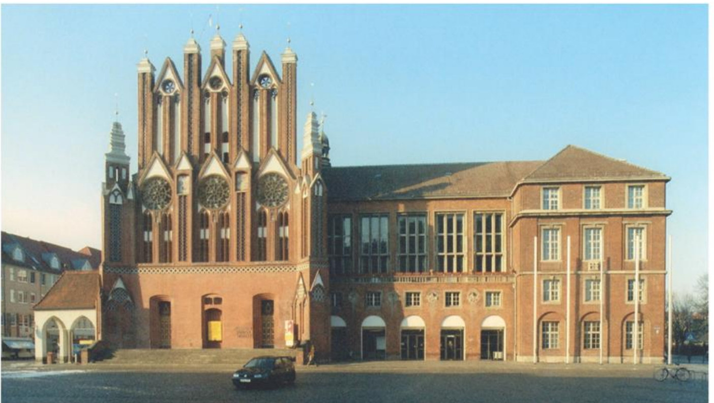
Frankfurt (Oder), Oberkirchplatz 1, Stadtpfarrkirche St. Marien von Südosten. Baubeginn Mitte 13. Jahrhundert, grundlegender Umbau und Erweiterung um 1350/80, Chorsüdanbau um 1520/22. 1826 Einsturz des Südturms, Sanierung 1826–30, Restaurierung durch Hans Berger-Schäfer 1921–27, dabei Aufsatz der hohen Schildmauern mit Wimpergreihe als Abschluss des Langhauses nach Restbefunden. 1995–98 Aufsetzen der Dachwerke über Chor und Langhaus. Nach Rückkehr der Chorfenster 2004 Rekonstruktion der Chorgewölbe.
