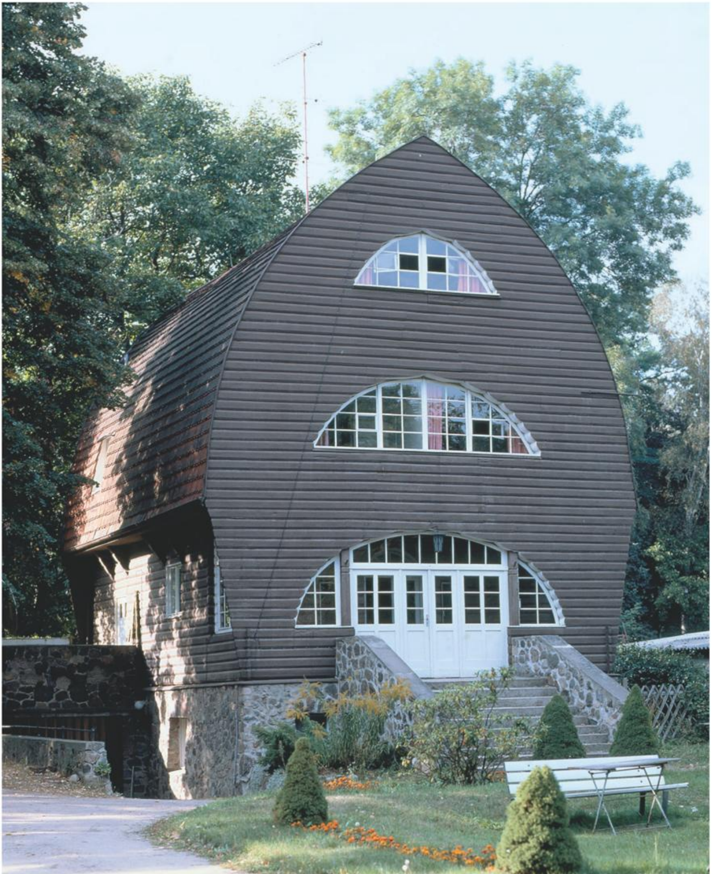
Bad Saarow (LOS), Uferstraße 12a, 13, Villa Parolo. Um 1924 von Fritz Glantz für den Börsenmakler Paul Zeidler entworfen. Tür wie Fensterflügel des exzentrisch gestalteten Schaugiebels sind herausnehmbar, so dass sich der dahinter liegende Raum als Loggia zum Garten und zum See öffnet. Sanierung 2002/03.
