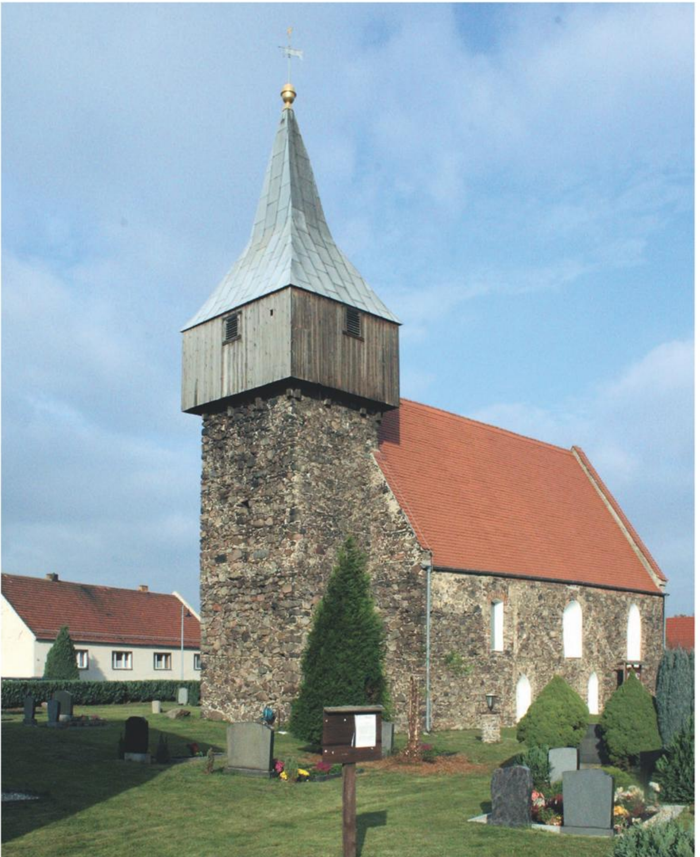
Grißen (Grešna; SPN), Wehrkirche. Rechteckiger flachgedeckter Feldsteinbau des 15. Jahrhunderts mit quadratischem Westturm, dieser mit vorkragendem Glockengeschoss aus verbrettertem Fachwerk und vierseitiger Spitze, wehrhafter Umbau wohl des 16. Jahrhunderts. Restauriert 1980.
