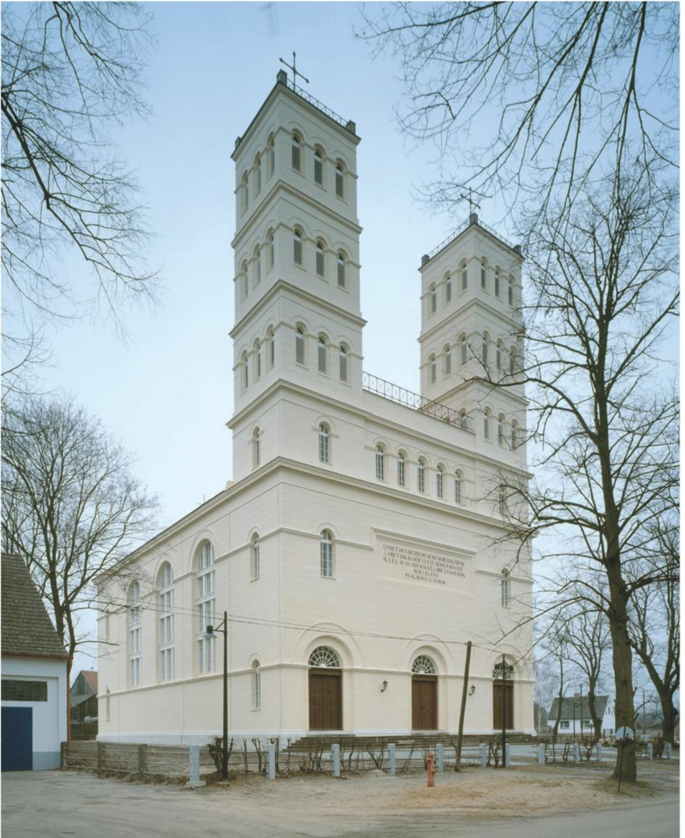
Straupitz (Tšup; LDS), Dorfkirche. Die Hallenkirche im Rundbogenstil mit zwei quadratischen Ecktürmen nach einem vereinfachten Entwurf Karl F. Schinkels von 1828–32 errichtet. Zuletzt 1992–95 restauriert. Der Sakralbau mit großartiger Fernwirkung gehört zu den Hauptwerken Schinkels im ländlichen Kirchenbau.
