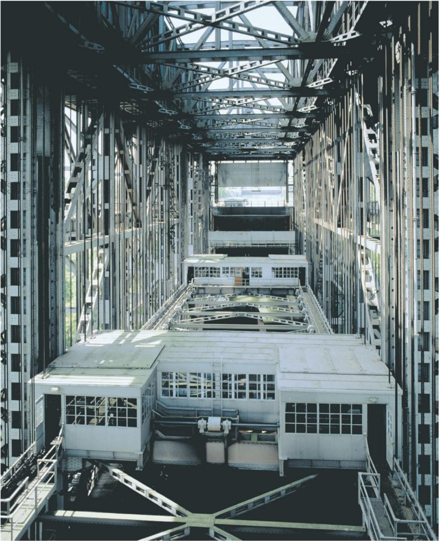
Niederfinow (BAR), Schiffshebewerk. 1927–34 erbautes Wasserverkehrsbauwerk des Oder-Havel-Kanals zur Überwindung eines 36 m hohen Geländesprungs. Das Gegengewicht-Hebewerk für den mit Wasserfüllung 4.290 t schweren Trog war zur Zeit seiner Inbetriebnahme eines der modernsten und größten Schiffshebewerke der Welt und ist noch heute in Betrieb.
