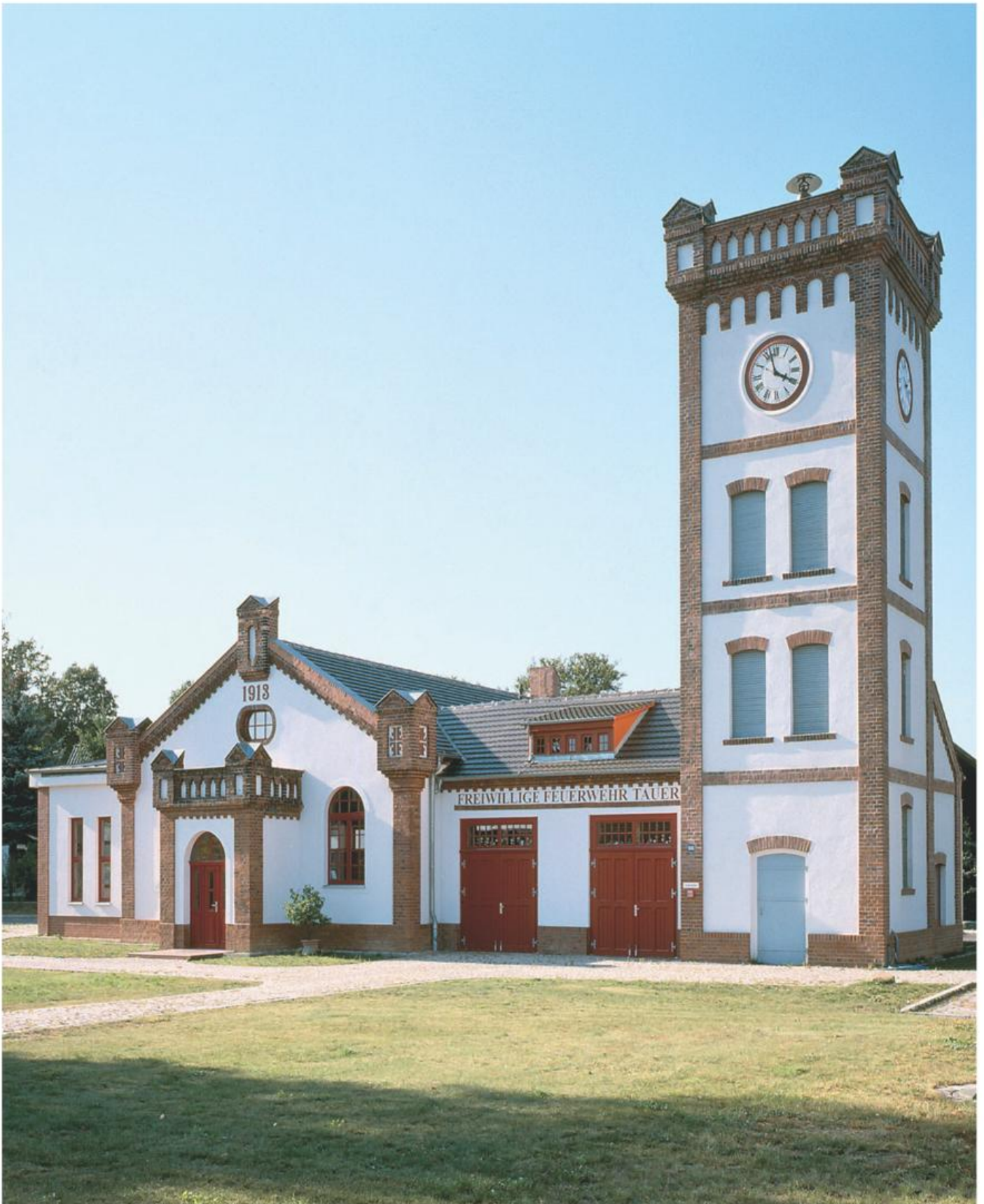
Tauer (Turje; SPN), Feuerwehrgerätehaus, 1896 neben dem Gutshaus im Ortskern gebaut. Dem Turm wurde 1913 eine Turnhalle angefügt. Im Zuge der jüngst vorgenommenen Renovierung behutsamer Umbau zum Einstellen moderner Löschfahrzeuge.
