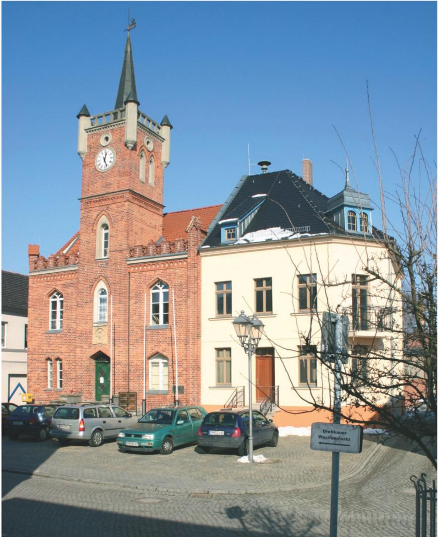
Drebkau (Drjowk; SPN), Rathaus. Kleiner neugotischer Ziegelbau von 1853 im Ortskern. Zweigeschossige Fassade mit abschließendem Zinnenkranz, der eingezogene quadratische Mittelurm mit Spitzhelm und Eckfialen. Gesamtes Gebäude jüngst restauriert.
