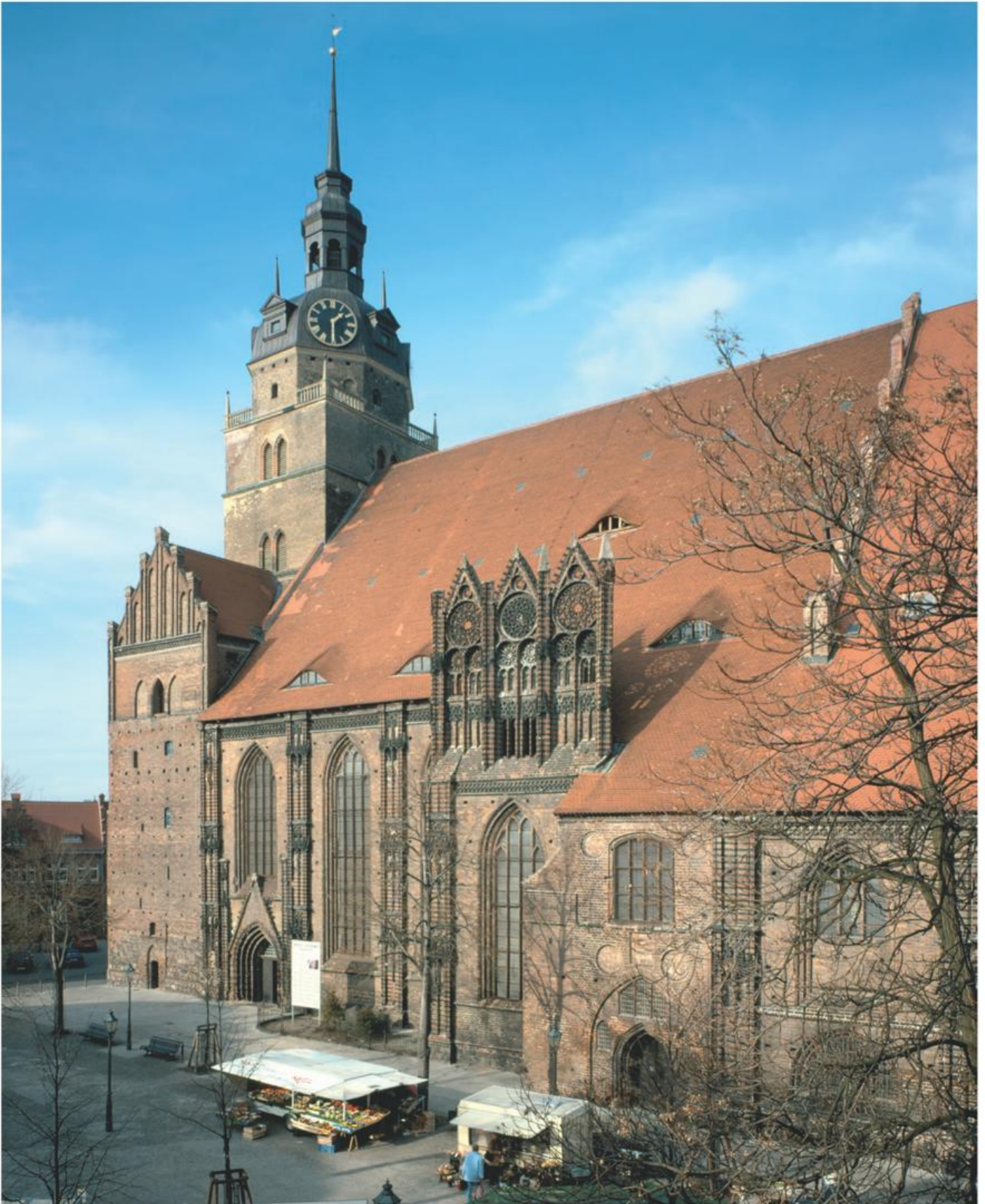
Brandenburg an der Havel, St. Katharinen-Kirche. Für den im späten 14. und 15. Jahrhundert entstandenen Neubau der spätgotischen Hallenkirche ist durch Inschrift Hinrich Brunsberg als Baumeister überliefert. Charakteristisch ist der reiche Bauschmuck aus bunt glasierten Ziegeln und Maßwerken.
