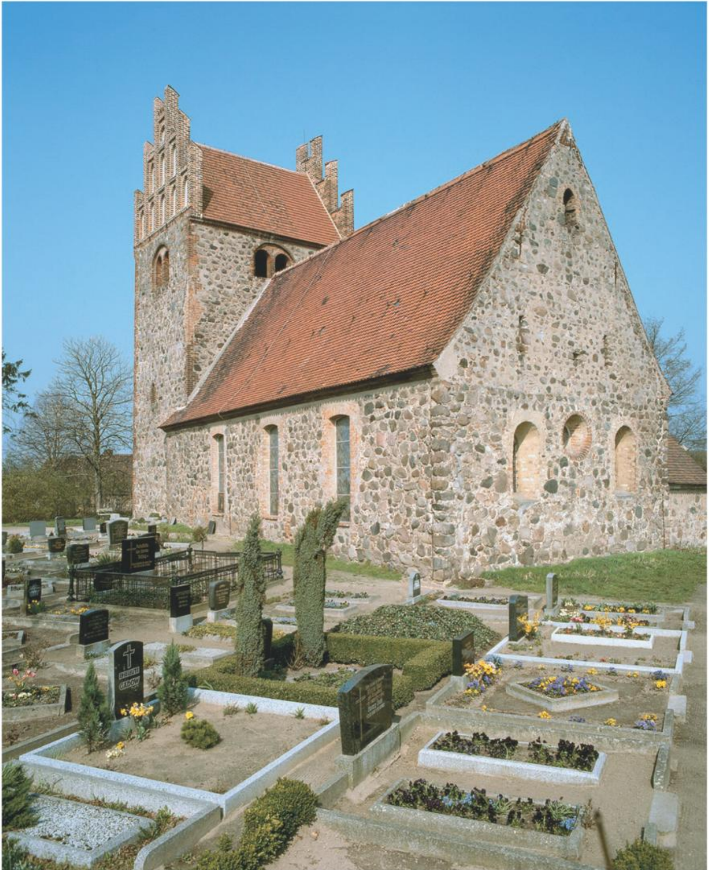
Herzberg/Mark (OPR), Dorfkirche. Der spätgotische Feldsteinbau zählt wegen seiner stattlichen Größe und teilweise noch bauzeitlichen Ausmalung zu den bedeutendsten mittelalterlichen Dorfkirchen Ruppins.
