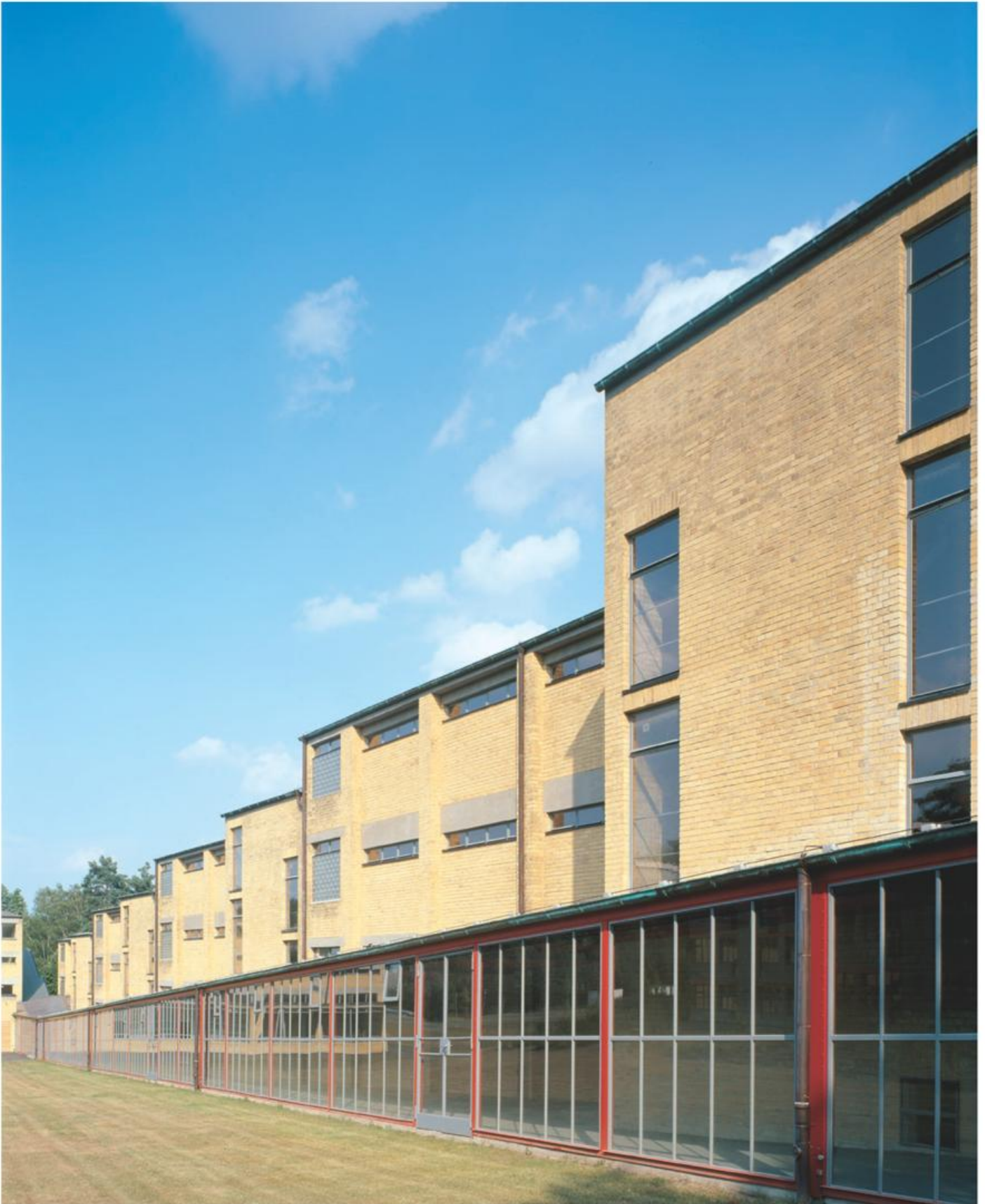
Bernau (BAR), Bundesschule des »Allgemeinen Deutschen Gewerkschaftsbundes«. Eines der bedeutendsten Beispiele moderner Bauhaus-Architektur in Brandenburg ist der von Bauhausdirektor Hannes Meyer entworfene Schulkomplex von 1928–30. Mit der aktuellen Sanierung ist es gelungen, den ursprünglichen Charakter der Anlage in großen Teilen zurückzugewinnen.
