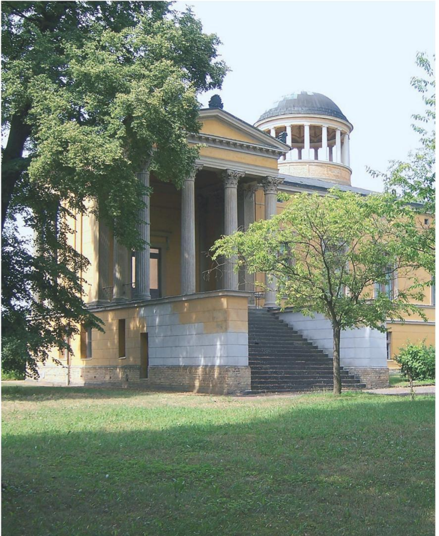
Potsdam, Schloss Lindstedt, Umbau eines barocken Gutshauses 1858–60 nach Skizzen Friedrich Wilhelms IV. und Plänen von Ludwig Persius, Ludwig F. Hesse, Friedrich A. Stüler und Ferdinand v. Arnim durch Hesse ausgeführt; umgebender Garten von Peter J. Lenné entworfen. Der vielsichtige, antikisierende kleine Schlosskomplex bildet den reizvollen Abschluss der nördlichen Achse des Parkbezirks von Sanssouci.
