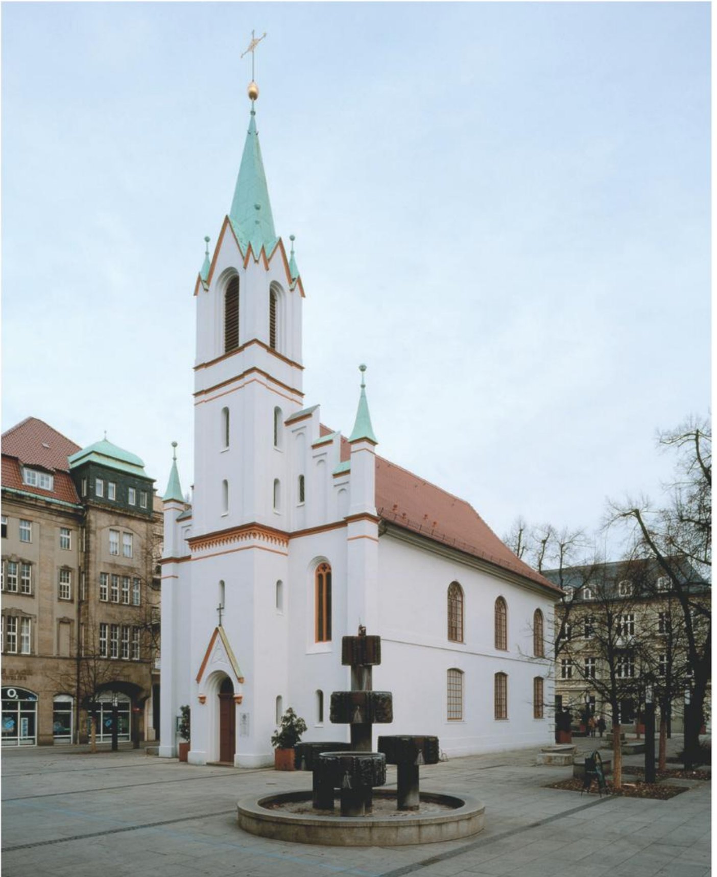
Cottbus (Chósebuz), Schloßkirchplatz, Schlosskirche. Die schlichte 1707–14 für die französisch-reformierte Gemeinde errichtete Kirche wurde um 1870 durch den Baurat Flemius in gelungener Weise um einen neugotischen Turm ergänzt. Die umfassende Sanierung des einzigen barocken Kirchenbaus in Cottbus wurde 2003 abgeschlossen.
