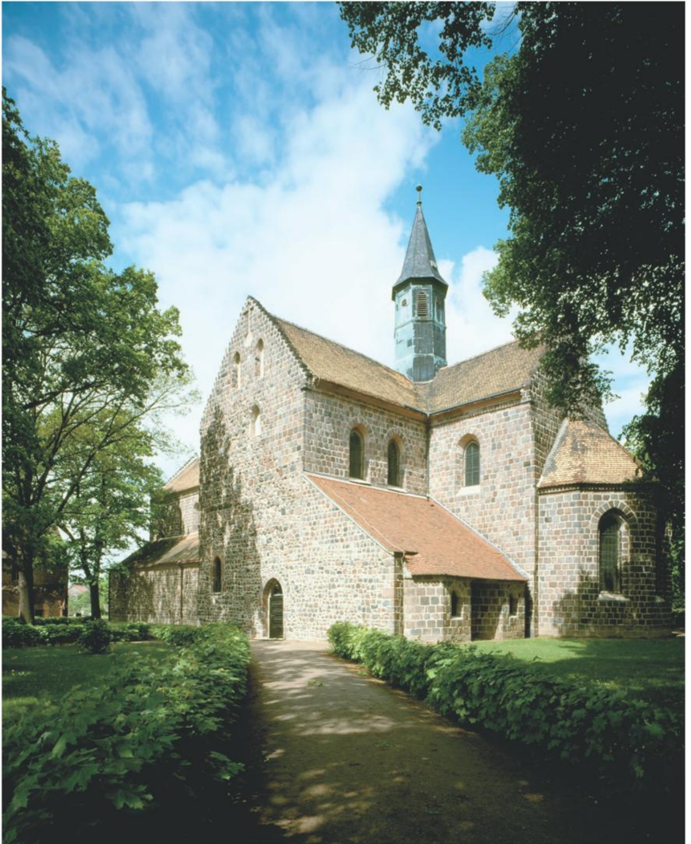
Kloster Zinna (TF), Zisterzienser-Klosterkirche. In seiner würdevollen Schlichtheit verkörpert der spätromanische Bau die Ordensideale Strenge und Bescheidenheit. Statt Backstein fanden die auch bei Dorfkirchen üblichen Feldsteine Verwendung, allerdings in außerordentlich sorgfältiger Bearbeitung.
