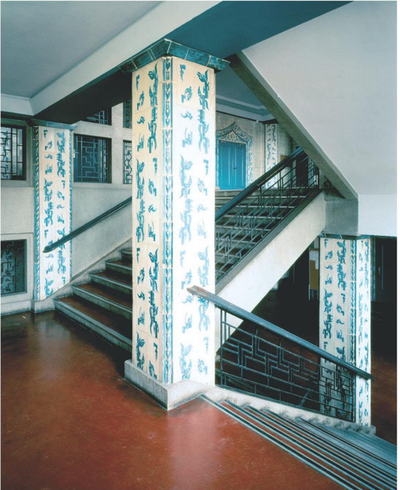
Frankfurt (Oder), August-Bebel-Straße 21, Schule, 1926/27 im Sinne der Reformpädagogik von Stadtbaumeister Josef Gesing errichtet. Von zwei Wohnhausgruppen flankiert, bildet sie den städtebaulichen Mittelpunkt der in den 1920er Jahren entstandenen Nuhen-Vorstadt. Ungewöhnliches Farbkonzept im Innern, Verkleidung der Treppenhaus- und Flurwände mit Fliesen der Rüppurer Fayence Fabrik, Karlsruhe. Die Farbfassung verschiedener Räume 1992/93 wiederhergestellt, Sanierung der Aula 2002.
