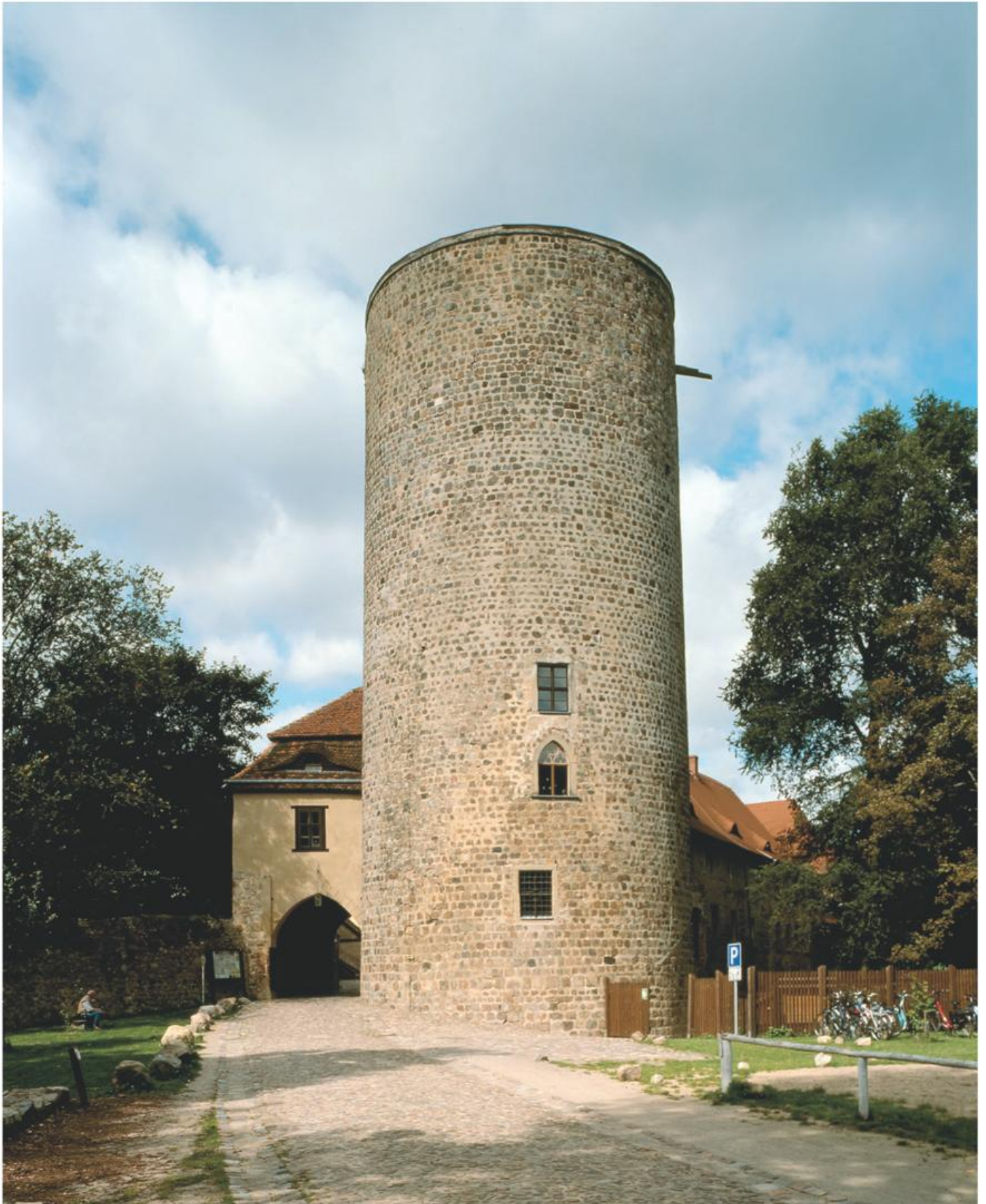
Raben (PM), Burg Rabenstein. Die auf einem Bergsporn des Hohen Fläming gelegene hochmittelalterliche Anlage gehört zu den wenigen Höhenburgen des Landes. Besonders eindrucksvoll ist der im frühen 13. Jahrhundert aus Feldsteinquadern errichtete Bergfried.
