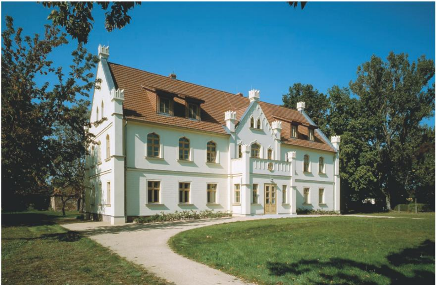
Potsdam, Am Neuen Palais 1, Kaiserbahnhof; 1904–09, Ernst E. v. Ihne. Der »Privatbahnhof« des eisenbahnbegeisterten Kaisers Wilhelm II. in Formen repräsentativer englischer Cottages wurde 1952 stillgelegt. Nach langem Leerstand zunehmend verfallen, erwachte er nach Restaurierung und Umbau als DB-Führungsakademie (2003–05) zu neuem Leben.
