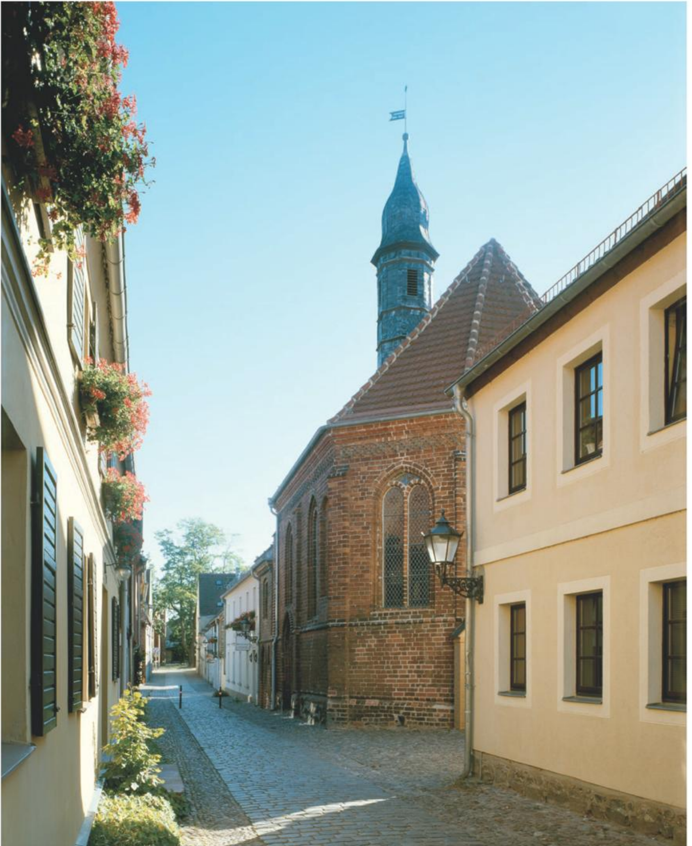
Neuruppin (OPR), Siechenstraße 4, Hospitalkapelle St. Lazarus. Die 1490 für das Siechenhospital gestiftete Kapelle ist ein wertvolles Zeugnis spätgotischer Baukunst im Ruppiner Land.
