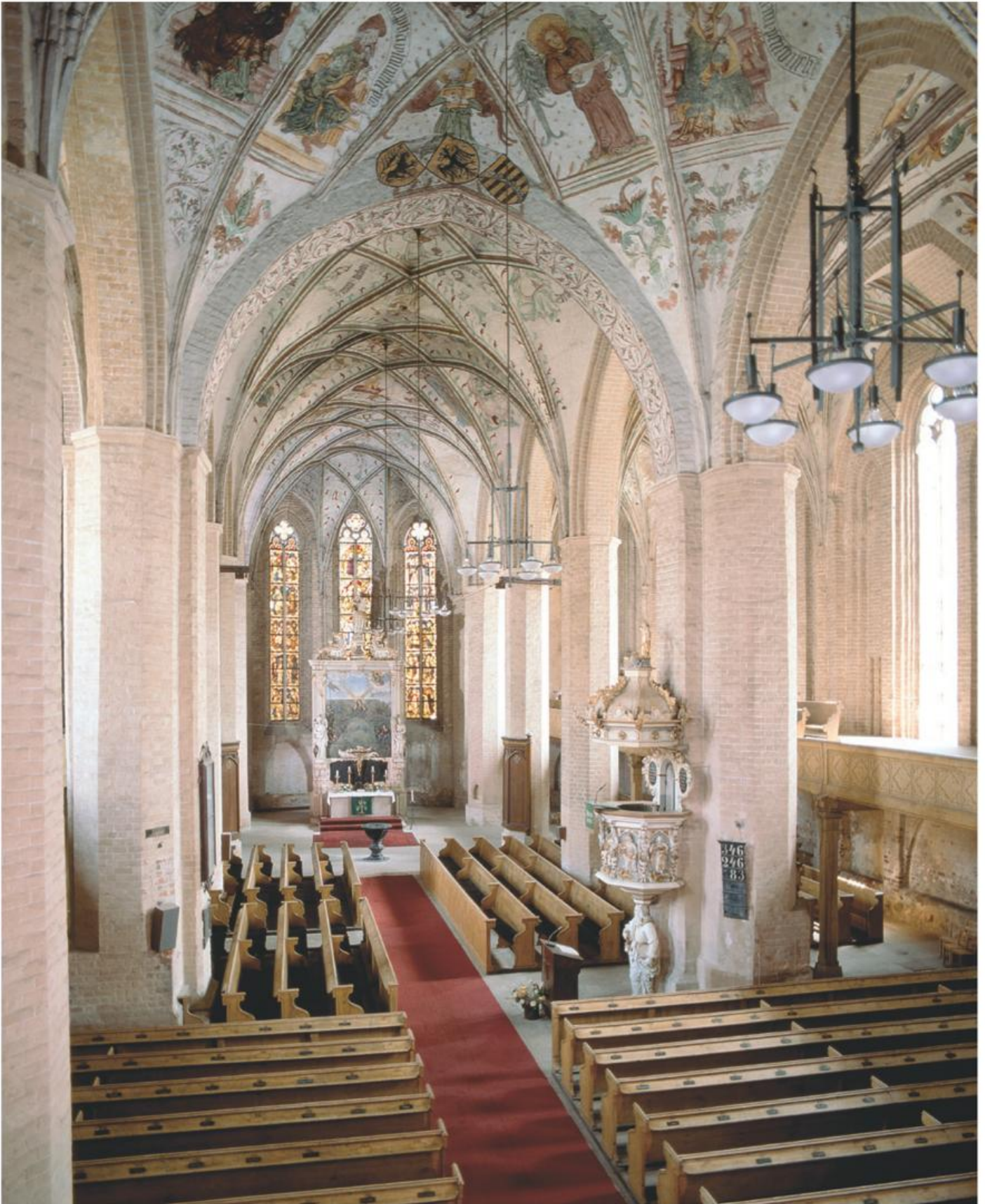
Herzberg/Elster (EE), Stadtpfarrkirche St. Marien. Dreischiffige Hallenkirche mit polygonalem Ostabschluss, Mitte 14. / Ende 15. Jahrhundert. Das Innere von der Restaurierung 1862–68 und einer reichen Ausstattung geprägt. Die Netzgewölbe ab 1415–1430/40 mit einem böhmisch beeinflussten, ikonographisch komplexen Bildprogramm ausgemalt. Bau und Ausstattung führen Herzbergs wirtschaftliche Blütezeit im 14./15. Jahrhundert eindrucksvoll vor Augen. Umfassende Restaurierung seit 1991.
