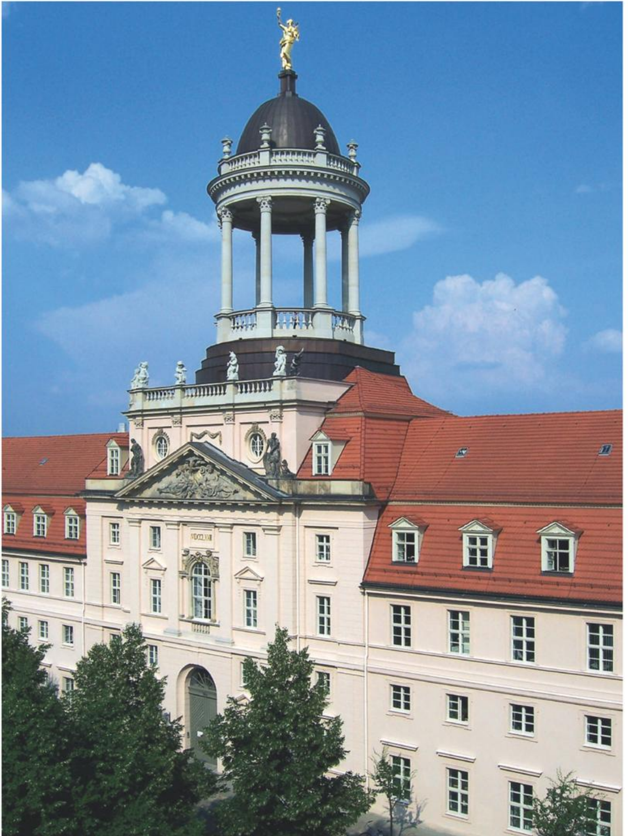
Potsdam, Lindenstraße 34a, Militärwaisenhaus, 1771–78, Karl v. Gontard. Der Mittelpavillon fügt mit dem aufgesetzten Tempietto der Stadtsilhouette einen markanten Bezugspunkt hinzu. 2000–04 Restaurierung der mehrflügeligen Gesamtanlage mit Wiederherstellung des kriegszerstörten Tempelchens.
