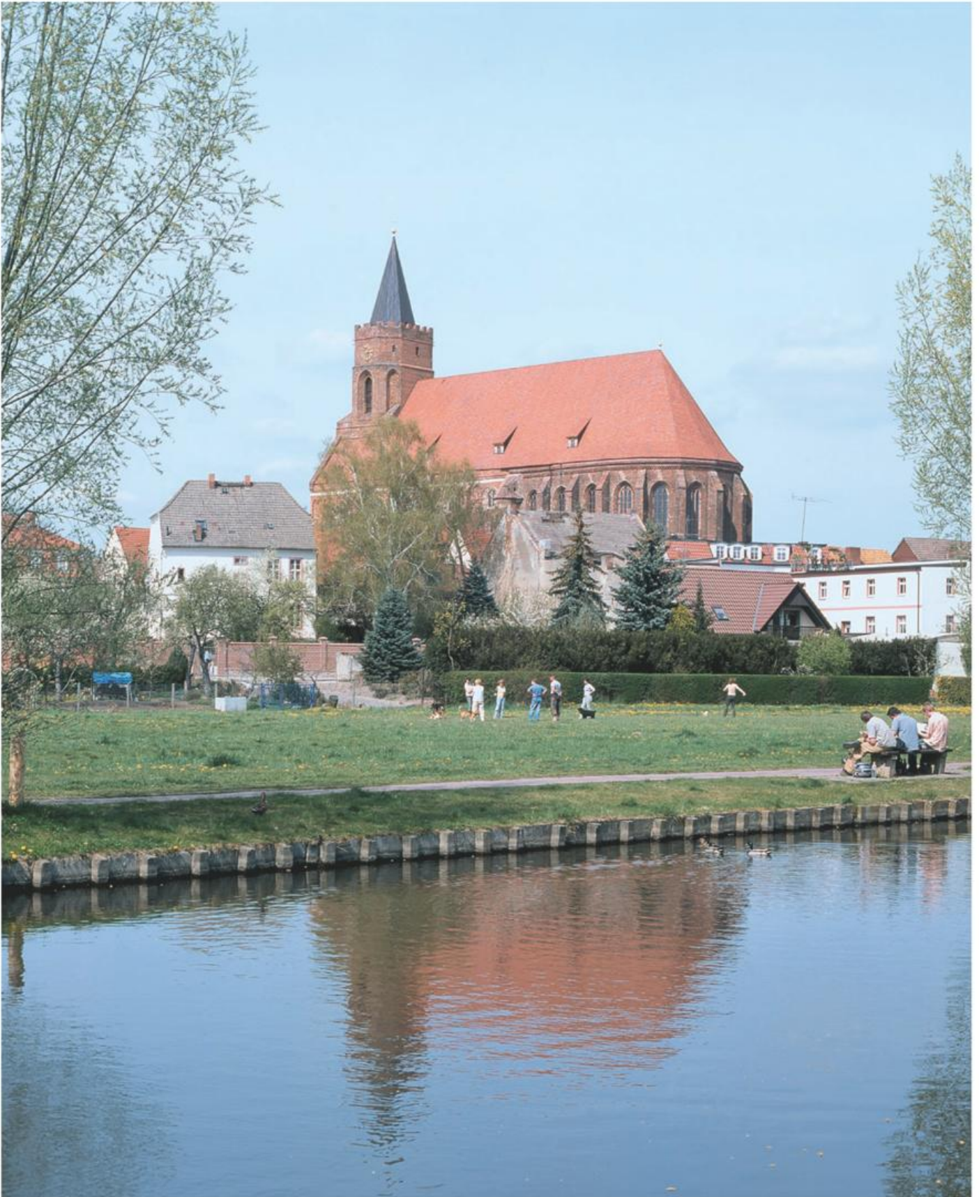
Beeskow (LOS), Kirchplatz 1, Pfarrkirche St. Marien. Dreischiffige Hallenkirche aus Backstein mit Hallenumgangschor des 15. Jahrhunderts. Vernichtung des gesamten Dachwerks und der Gewölbe 1945, Einsturz der Chorarkaden 1948. Beginn der Sicherungsmaßnahmen 1991, bis 1998 offene Ruine.
