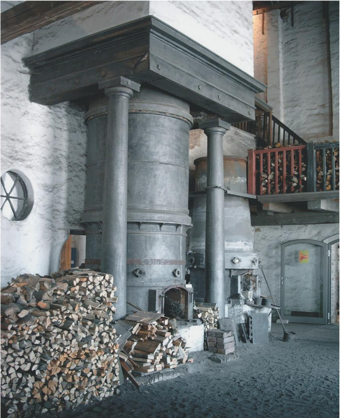
Peitz (Picnjow; SPN), Hüttenwerk, bestehend seit dem 16. Jahrhundert. Der 1831 in Betrieb genommene Kupolofen ist ein Schachtofen, in dem Metalle geschmolzen werden. Hier entsteht durch Einschmelzen von Eisengussbruch Gusseisen. Der etwa 10 m hohe Ofen ähnelt in Aufbau und Funktionsweise einem Hochofen, ist jedoch aufgrund seiner geringeren Temperaturleistung nicht geeignet, Erz aususchmelzen.
