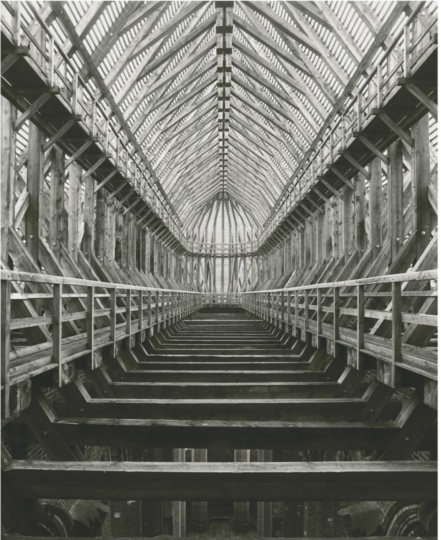
Beeskow (LOS), Pfarrkirche St. Marien (neues Dachwerk). Der beeindruckende neue Dachstuhl wurde 1998/99 unter freier Adaption der großen mittelalterlichen Konstruktionen in Holz ausgeführt. Auch im Kircheninneren raumbildend, da er von Kirchenschiff und Chorraum in ganzer Höhe eingesehen werden kann.
