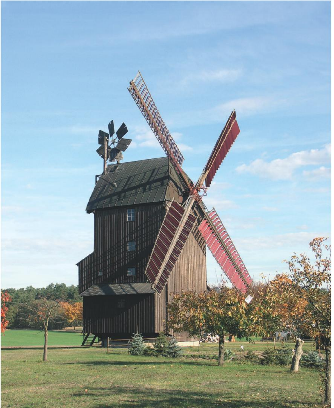
Schönewalde (EE), Paltockmühle. 1815 in Egsdorf bei Baruth als Bockwindmühle errichtet, 1940 demontiert und nach Schönewalde gebracht. Hier als Paltockwindmühle wieder aufgebaut, 1941–72 in Betrieb, 1992 saniert.
