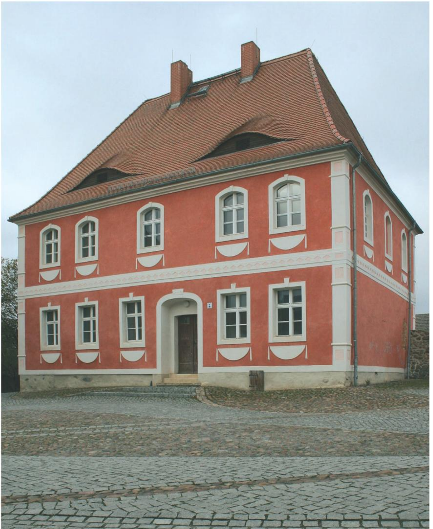
Calau (Kalawa; OSL), Burgplatz 6, sogenanntes Burglehenhaus. Großzügiger zweigeschossiger Putzbau von 5 : 3 Achsen unter Walmdach in unmittelbarer Nachbarschaft mittelalterlicher Burgreste und zu Fragmenten der Stadtmauer. Inschriftlich 1716, im Kern jedoch älter, nachgewiesen 1684 (d).
