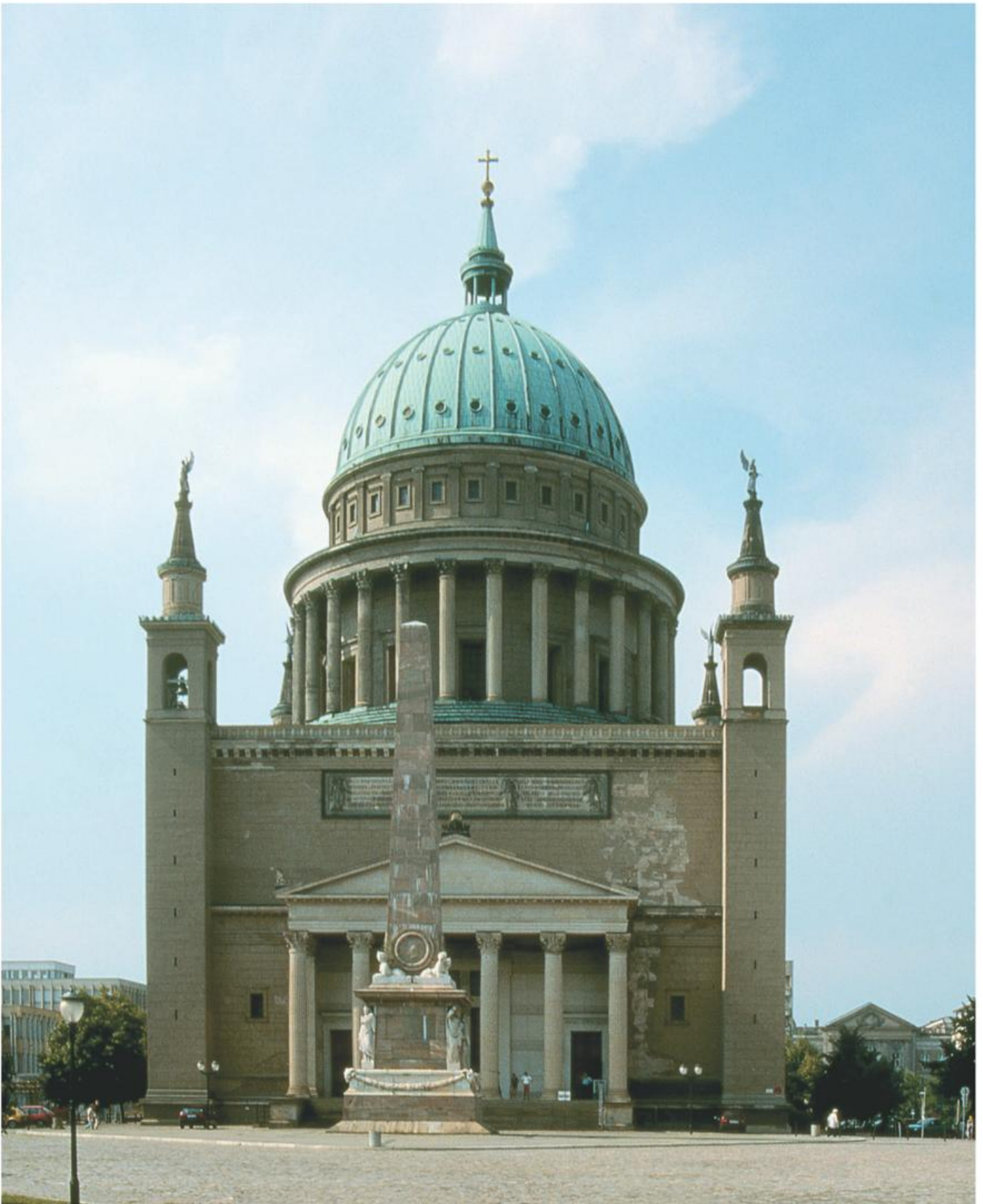
Potsdam, Am Alten Markt, Nikolaikirche. Nach Karl F. Schinkels Entwurf 1830–35 von Ludwig Persius und 1845–48 von Friedrich A. Stüler ausgeführt. Der klassizistische Zentralbau mit mächtiger, Stadt und umgebende Havellandschaft beherrschender Kuppel ist einer der bedeutendsten Entwürfe Schinkels. Das Denkmal von nationaler Bedeutung wird derzeit restauriert.
