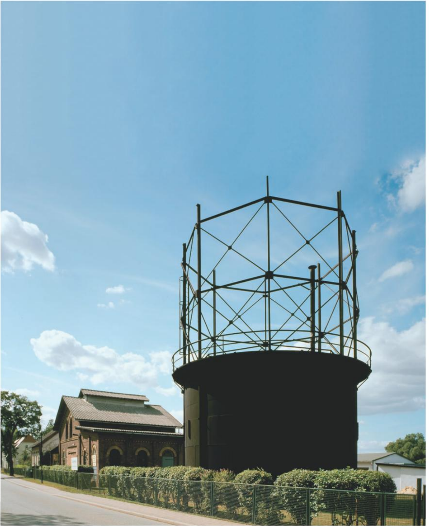
Neustadt/Dosse (OPR), Gaswerk, 1902/03, in Betrieb bis 1980; heute Museum. Das Gas wurde aus Steinkohle durch sogenannte »trockene« Destillation gewonnen. Als Nebenprodukt entstand Koks. Komplett erhaltenes Ensemble mit der entsprechenden technischen Ausstattung.
