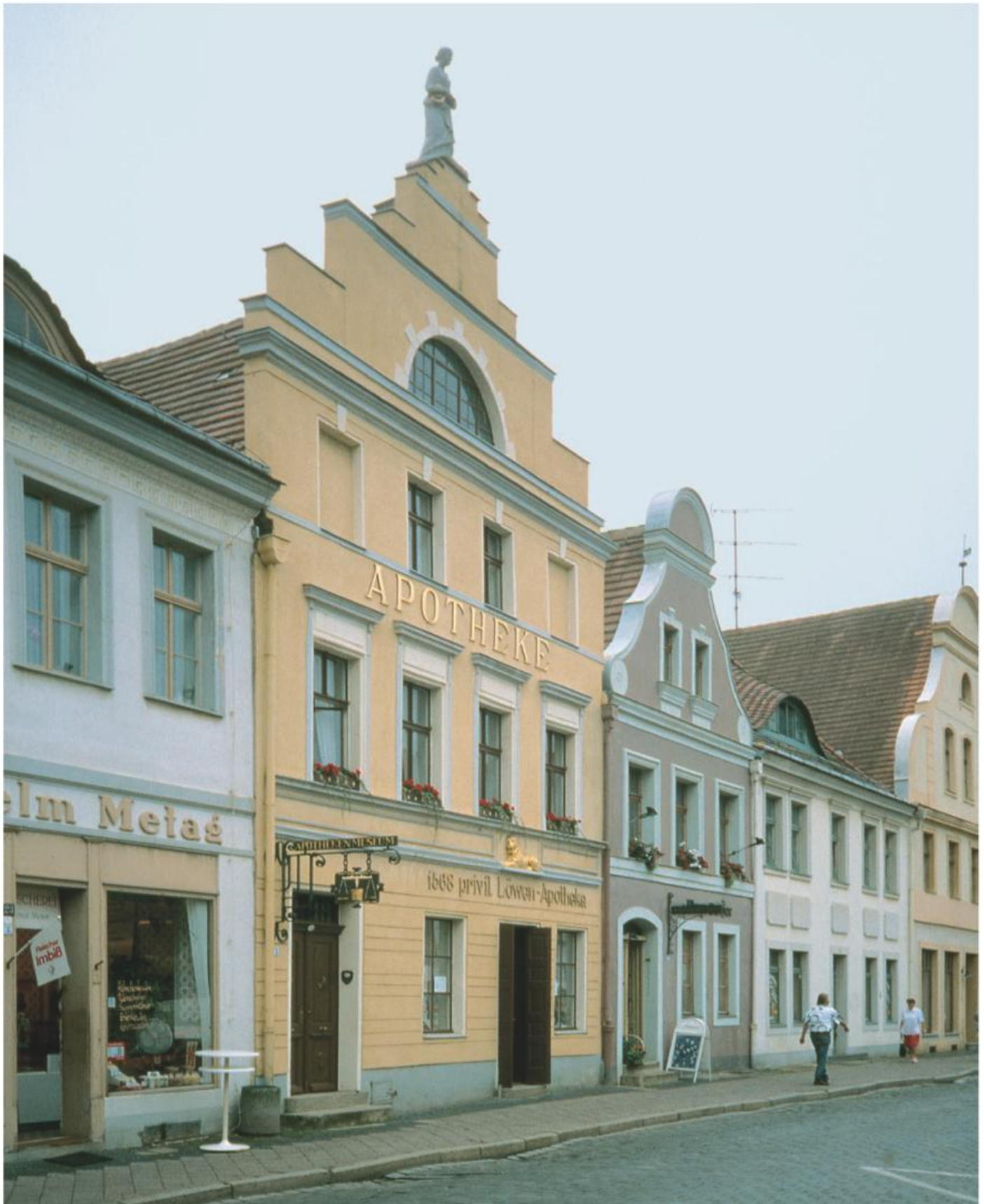
Cottbus (Chósebusz), Altmarkt 24. Die Bauten der traditionsreichen Löwenapotheke gehören zu den letzten in Cottbus, die vom Keller bis zum Dachwerk Bausubstanz aus dem zweiten Drittel des 16. Jahrhunderts bzw. späten 17. Jahrhunderts bewahrt haben und damit eindrucksvoll Konstruktionsweisen dieser Zeit dokumentieren. Besonders interessant das Vorderhaus mit dem mächtigen, von einer Hygieiafigur bekrönten Staffelgiebel.
