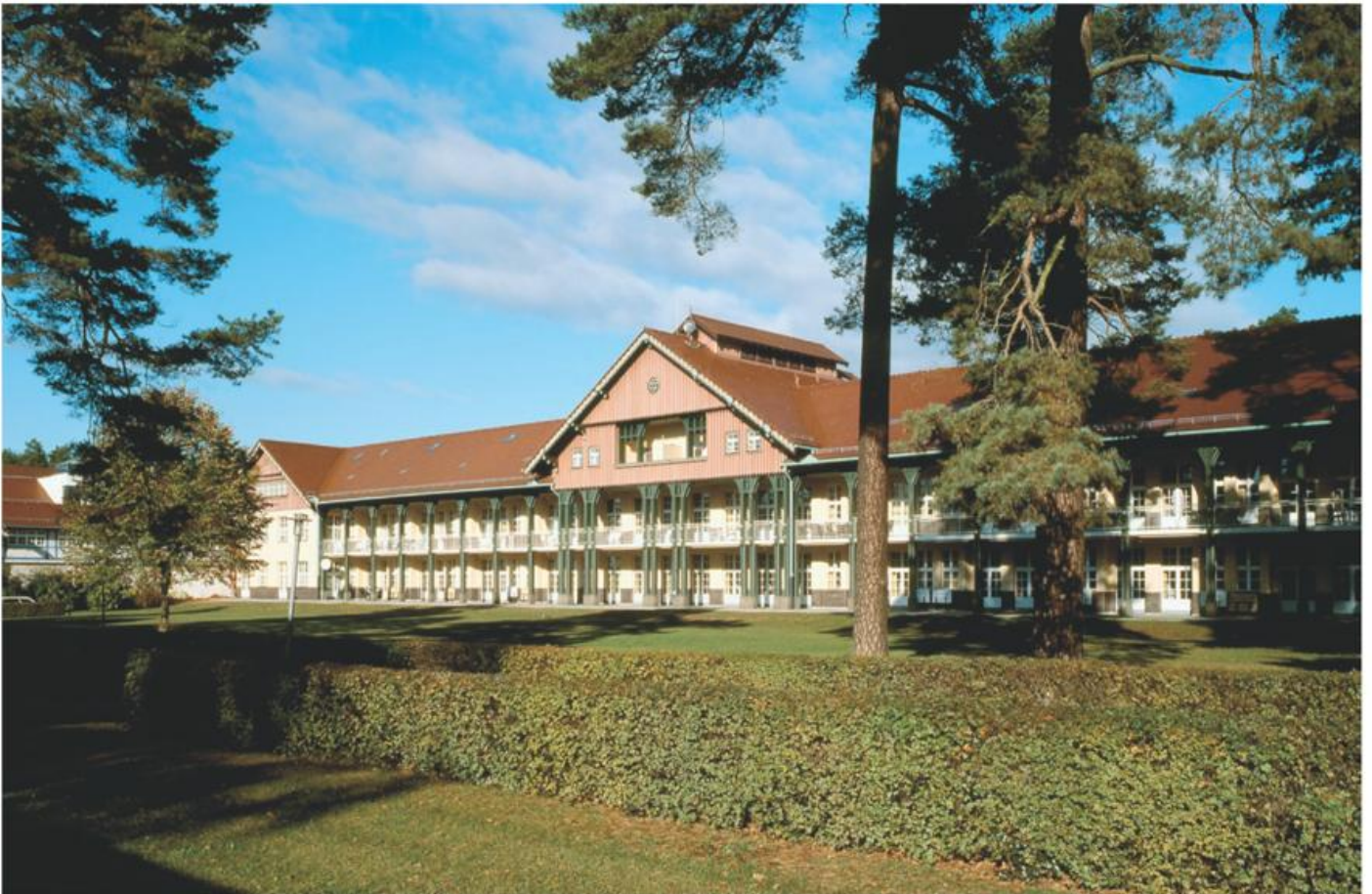
Brieske (Brezk; OSL), Arbeiter-Gartenstadt »Grube Marga«, 1907–15 nach Entwurf von Georg Heinsius von Mayenburg für die »Ilse-Bergbau-Actiengesellschaft«. Eine der ersten deutschen Gartenstädte, denkmalgerechte Sanierung 1998 begonnen.
