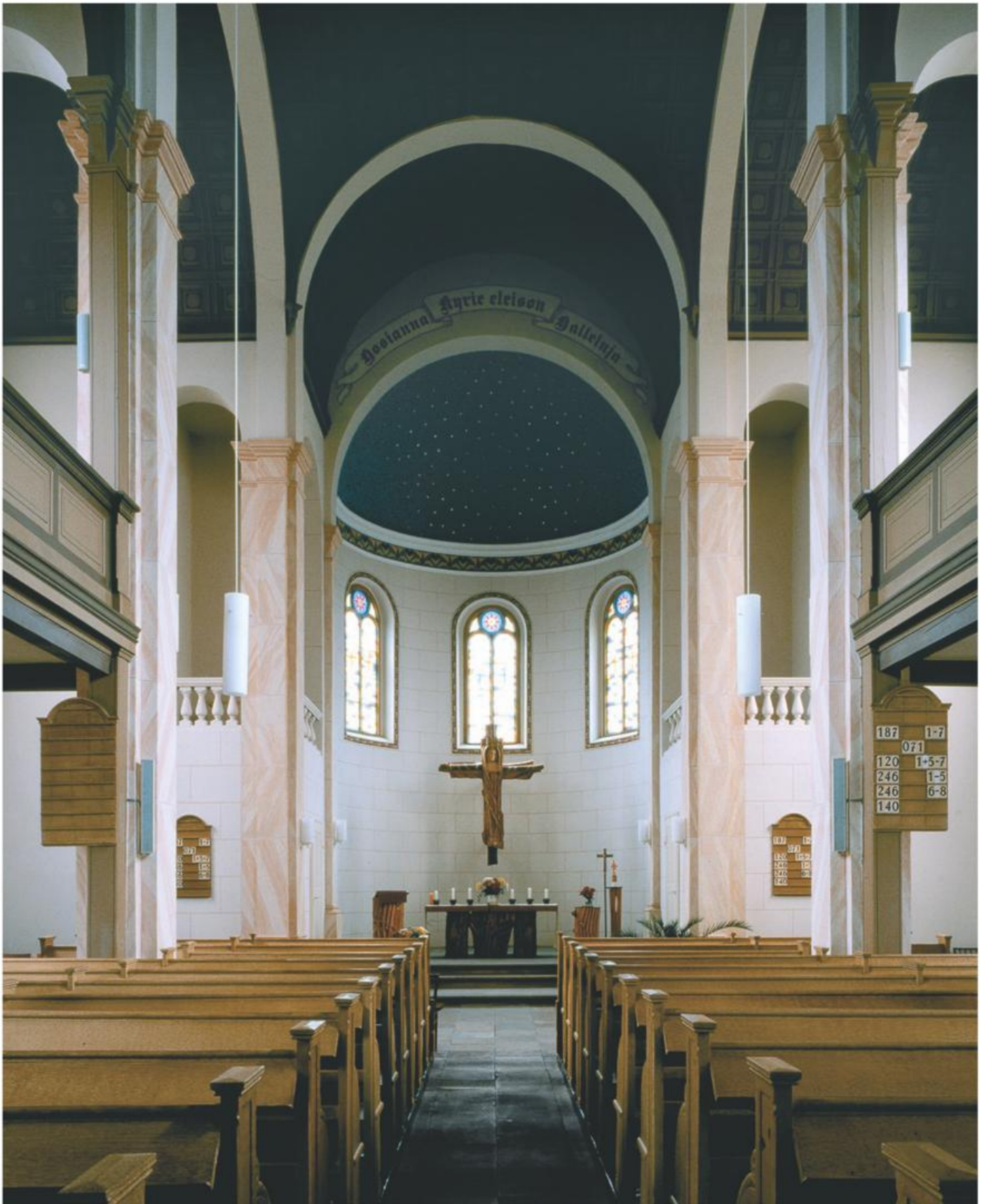
Cottbus (Chósebuz), Karlstraße 80, Evangelisch-Lutherische Kreuzkirche. Der turmlose, kreuzförmige Ziegelbau 1878/79 nach Entwurf des Baurats Abel aus Lauban in neuromanischen Formen errichtet. Nach der Instandsetzung des Außenbaus in den Jahren 1999/2000 wurde der Innenraum mit der prägnanten kassettierten Tonne 2002 fertiggestellt.
