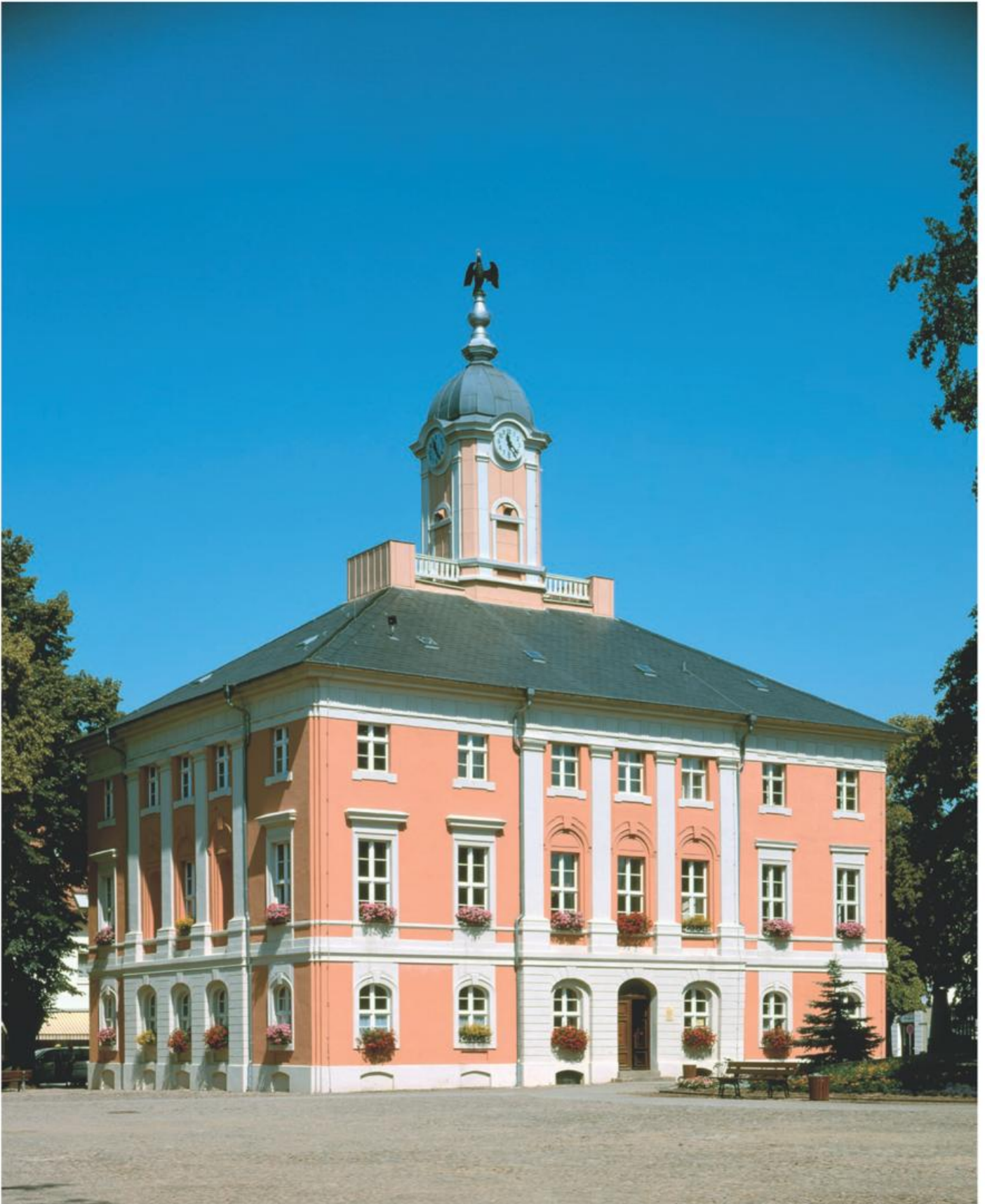
Templin (UM), Rathaus. 1746–51 nach Plänen von Karl S. Schmidt und Johann G. Kemmeter auf dem Marktplatz errichtet. Zwei kriegszerstörte Achsen wurden 1963–65 wiederhergestellt. 1991–98 erfolgte die letzte durchgreifende Instandsetzung.
