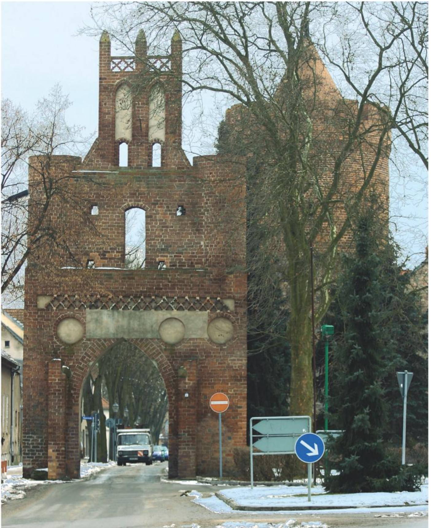
Mittenwalde (LDS), Berliner Tor. Vom spätmittelalterlichen Haupttor ein runder Feldsteinturm erhalten; sein Abschluss mit Zinnenkranz und Kegeldach von 1898. Das Vortor vom Ende des 15. Jahrhunderts mit schönem Ziergiebel flankiert von zwei Rundtürmen. Die Anlage gehört zu den letzten mittelalterlichen Profandenkmalen in der Region.
