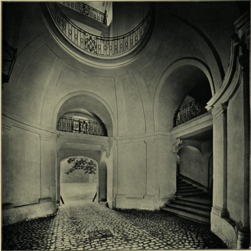
Abb. 121. Militärwaisenhaus Lindenstraße, Treppenhalle mit Durchfahrt Aufnahme der Kgl. Meßbildanstalt
