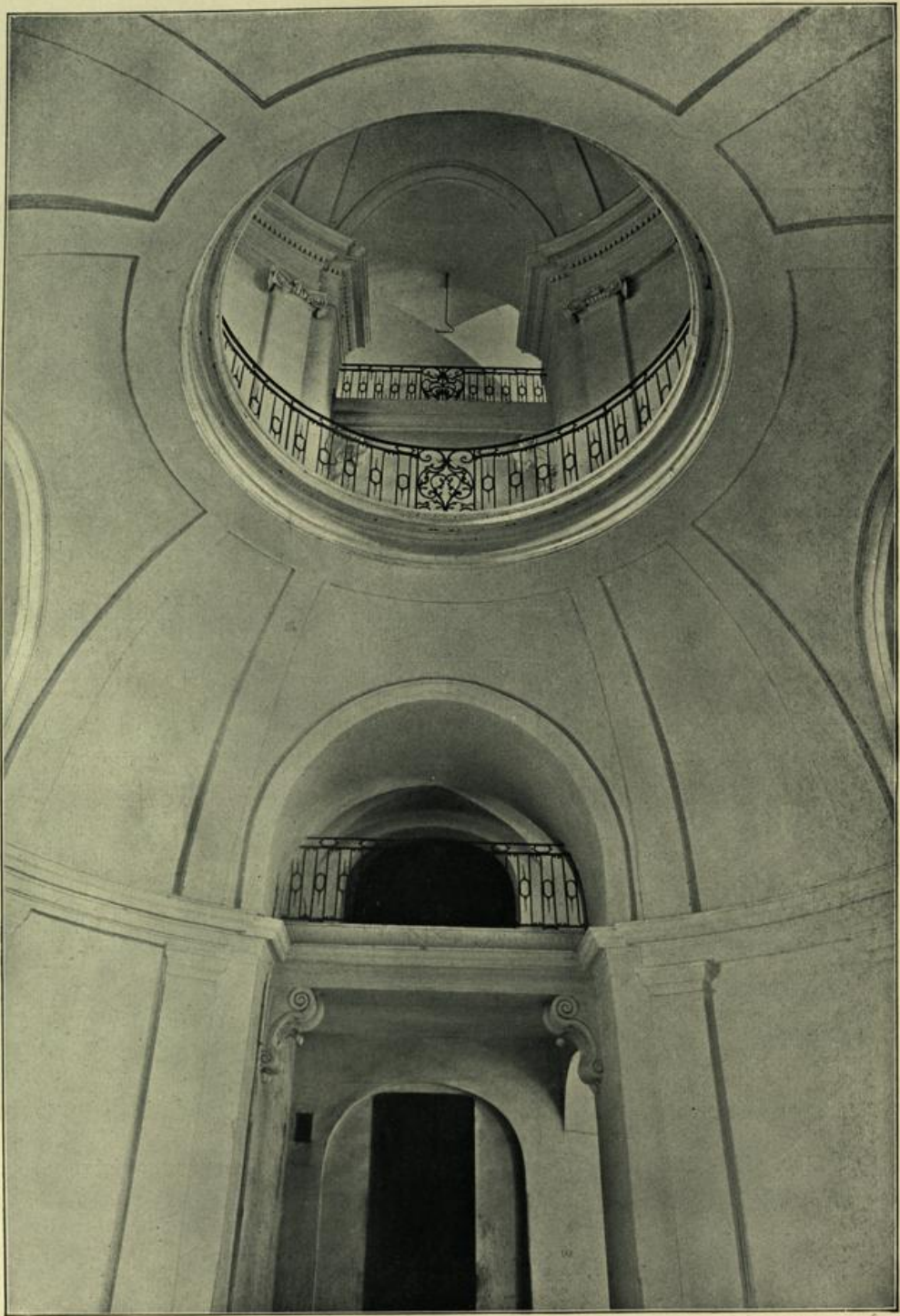
Abb. 122. Militärwaisenhaus Lindenstraße, Treppenhalle, Blick von der Durchfahrt nach oben
