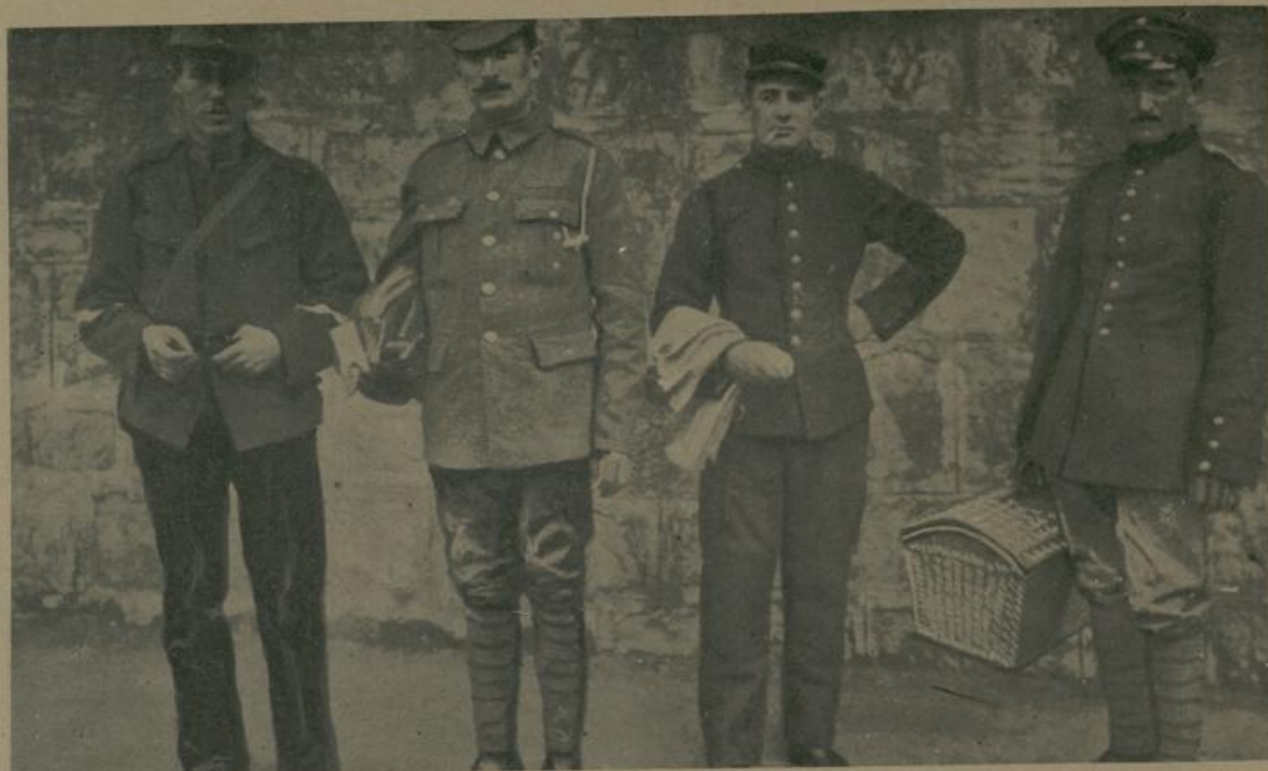
אורף נוימראלע ערד. א דייטשער, א ענגלישער אין א סראנצוווישער סאלדאט נעהען אונזער אויסזיכט סון א שווייצער סאניטעטס-סאלדאט אָננעמען די פּאָסט.
