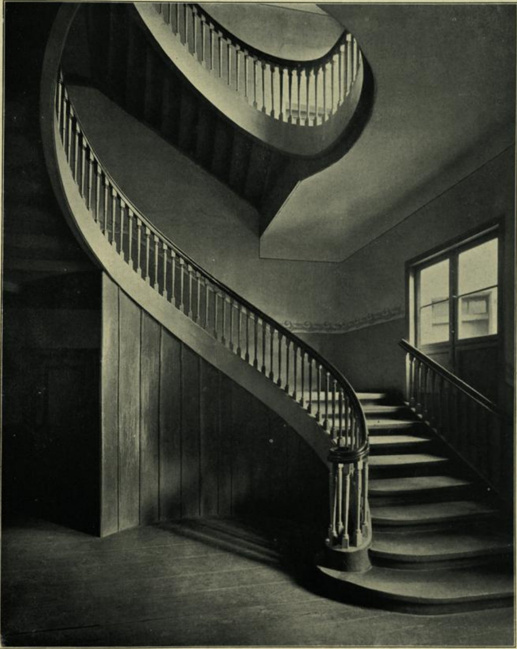
Abb. 182. Am Kanal 63 Aufnahme der Kgl. Meßbildanstalt
