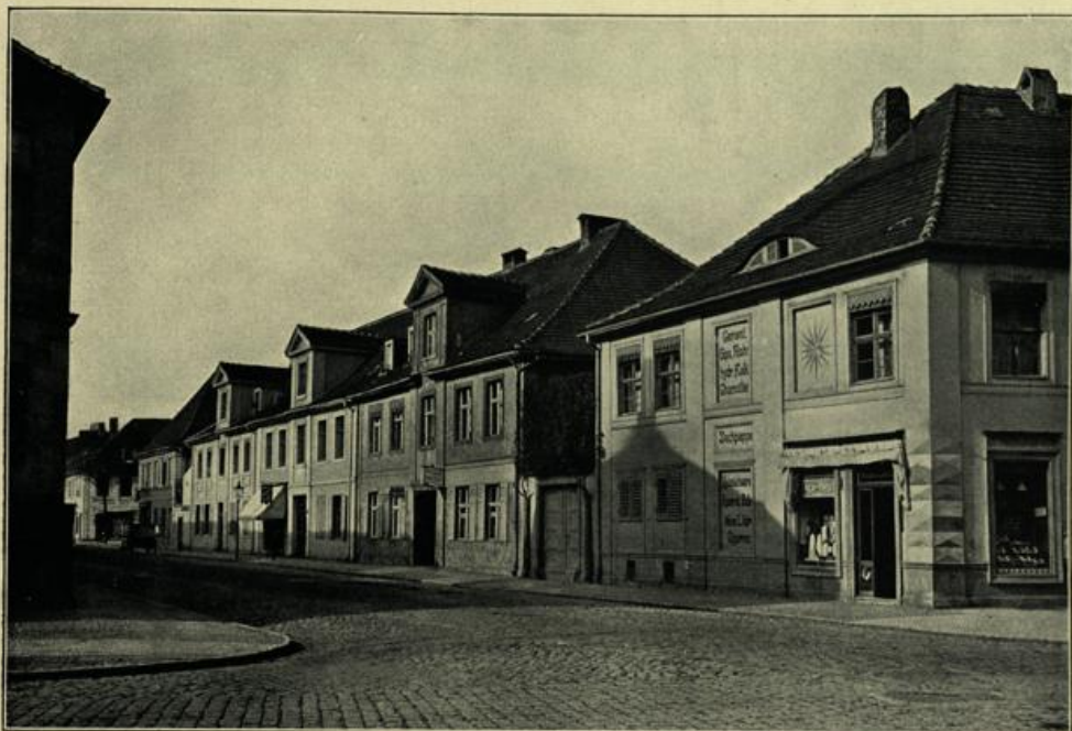
Abb. 45. Einheitliche Blockfront der zweiten Städterweiterung von 1733—37 Architekten Gayette und Berger
