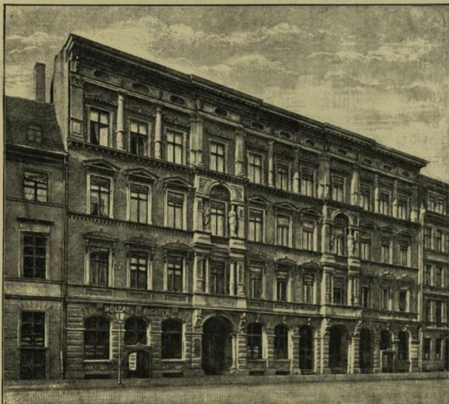
Der Neubau in der Klosterstraße 45.
