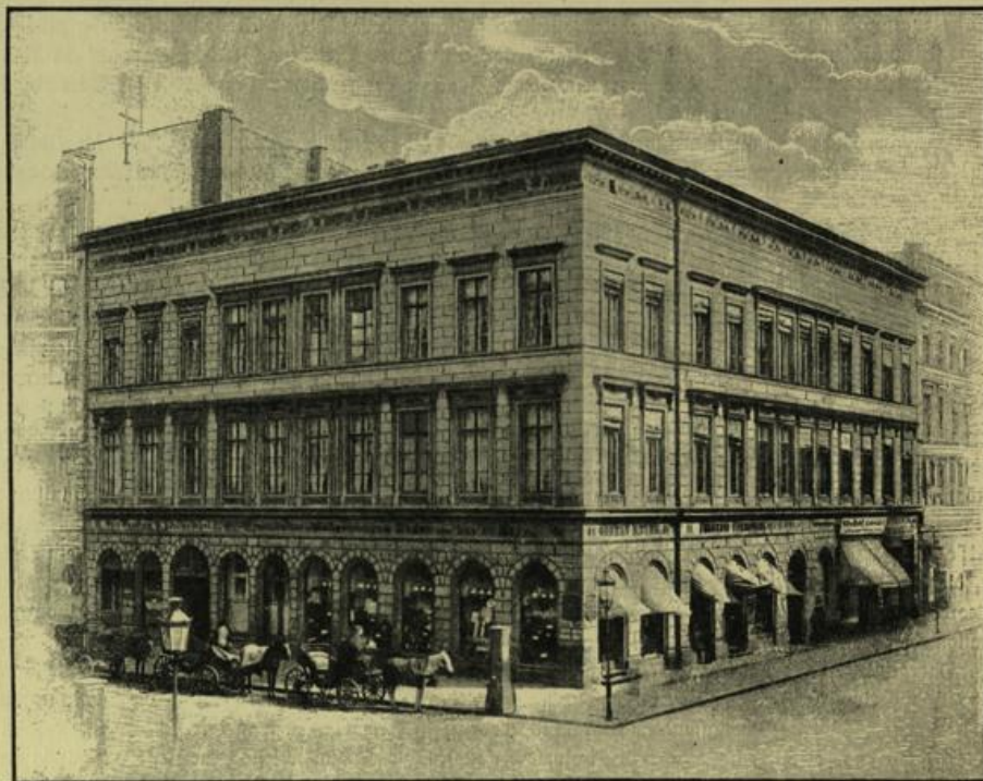
Der Neubau der Maison de Refuge.
