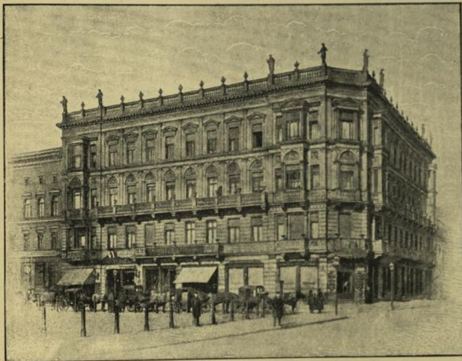
Der Neubau der Fondation Alard.
