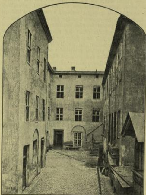
Die ehemaligen Gebäude des französischen Gymnasiums im Hofe der Niederlagstraße 1 u. 2.
