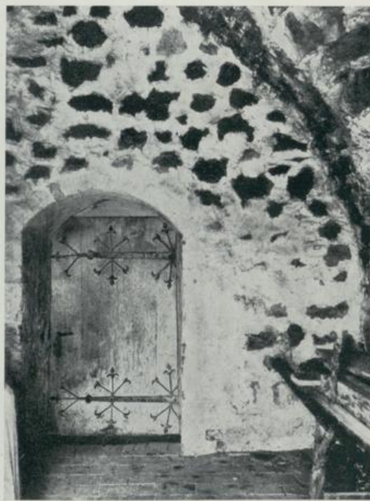
35. Stegeliß. Kirche. Tür mit mittelalter- lichen Beschlägen im Turmuntergeschoß
