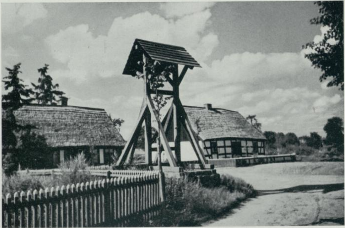
27. Negow. Wohnhäuser und hölzerner Glockenstuhl
