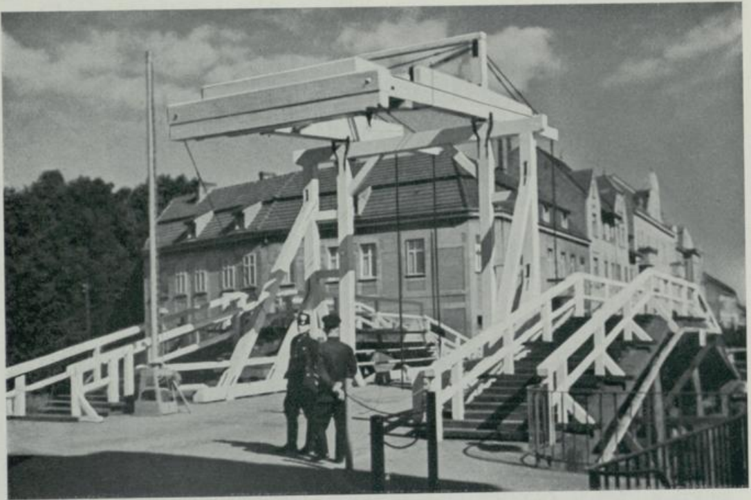
387. Zehdenick. Zugbrücke über die Havel
