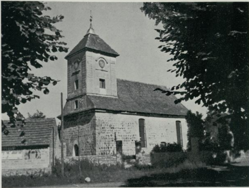
383. Zabelsdorf. Kirche von Südwesten
