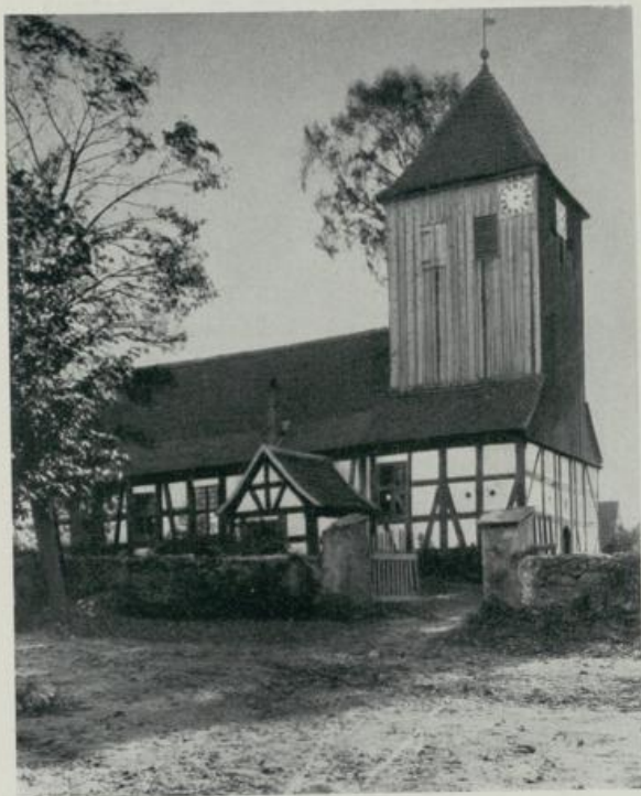
204. Bredereiche. Kirche von Südwesten
