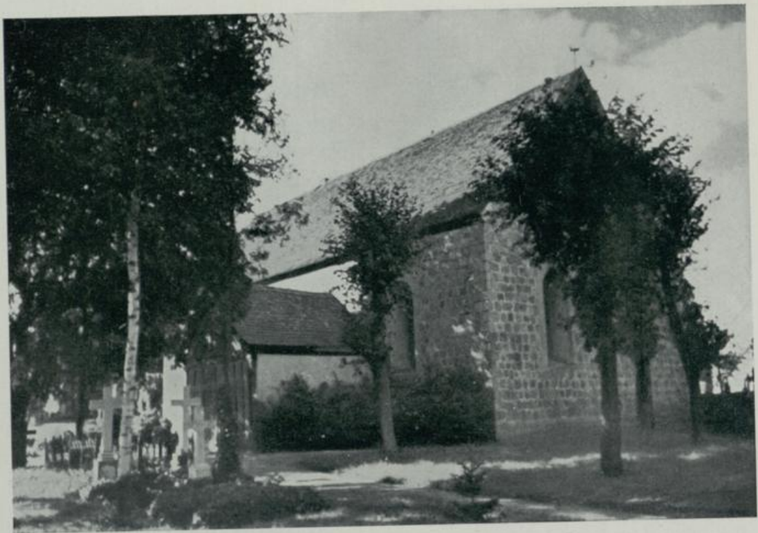
370. Thomsdorf. Kirche von Südosten
