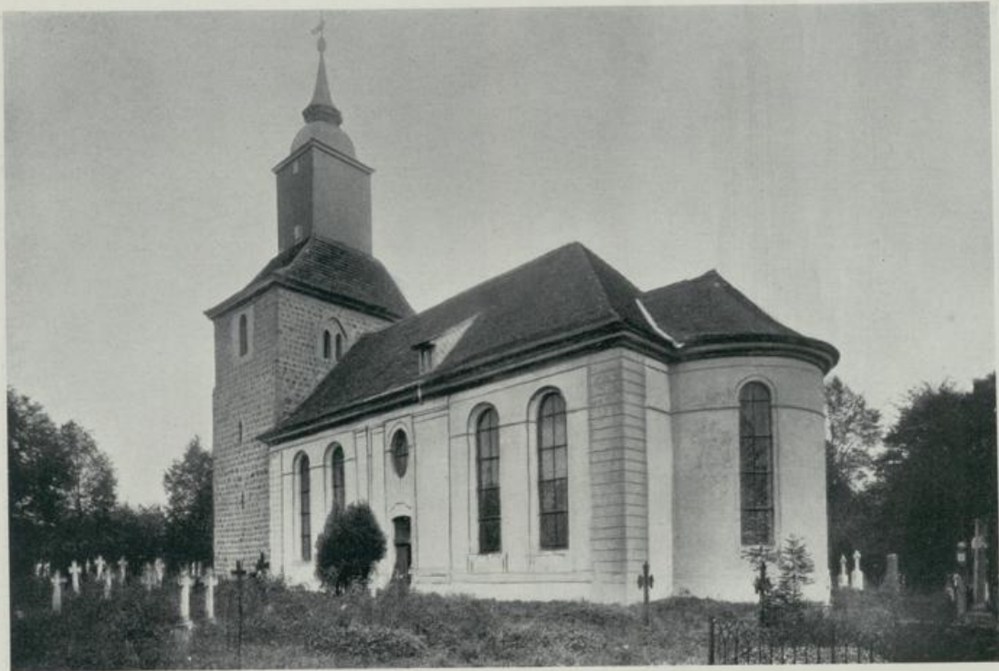
258. Klein Muck, Kirche von Südosten
