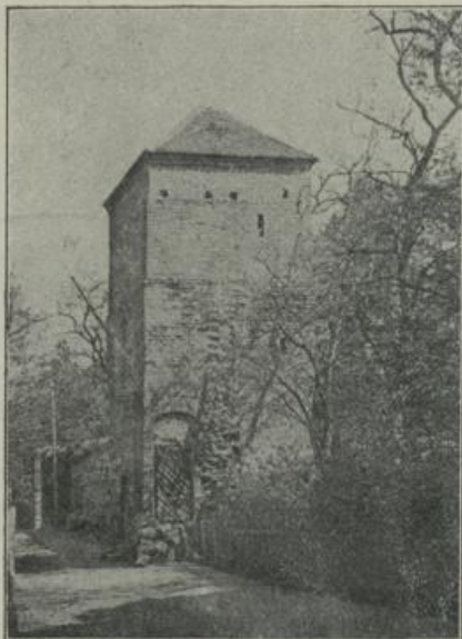
Abb. 226. Prenzlau. Weichhaus nördlich vom Walltor („Seilerturm“).
