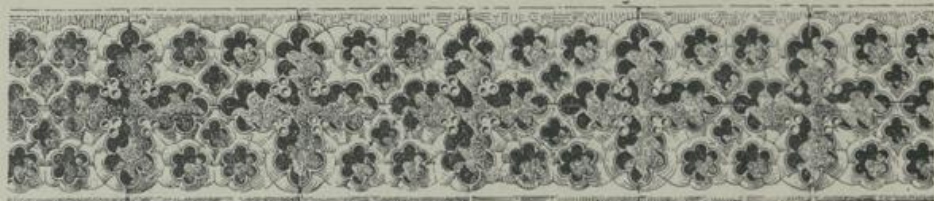
Abb. 159. Prenzlau. Fries am Südbau der Marienkirche.
