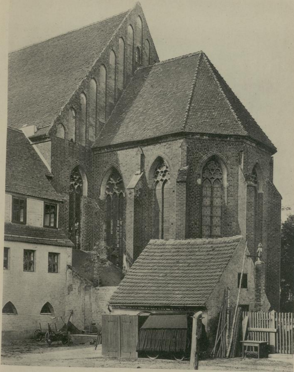
Drenzlau. Ehemalige Dominikanerkirche. Chor von Südosten.
