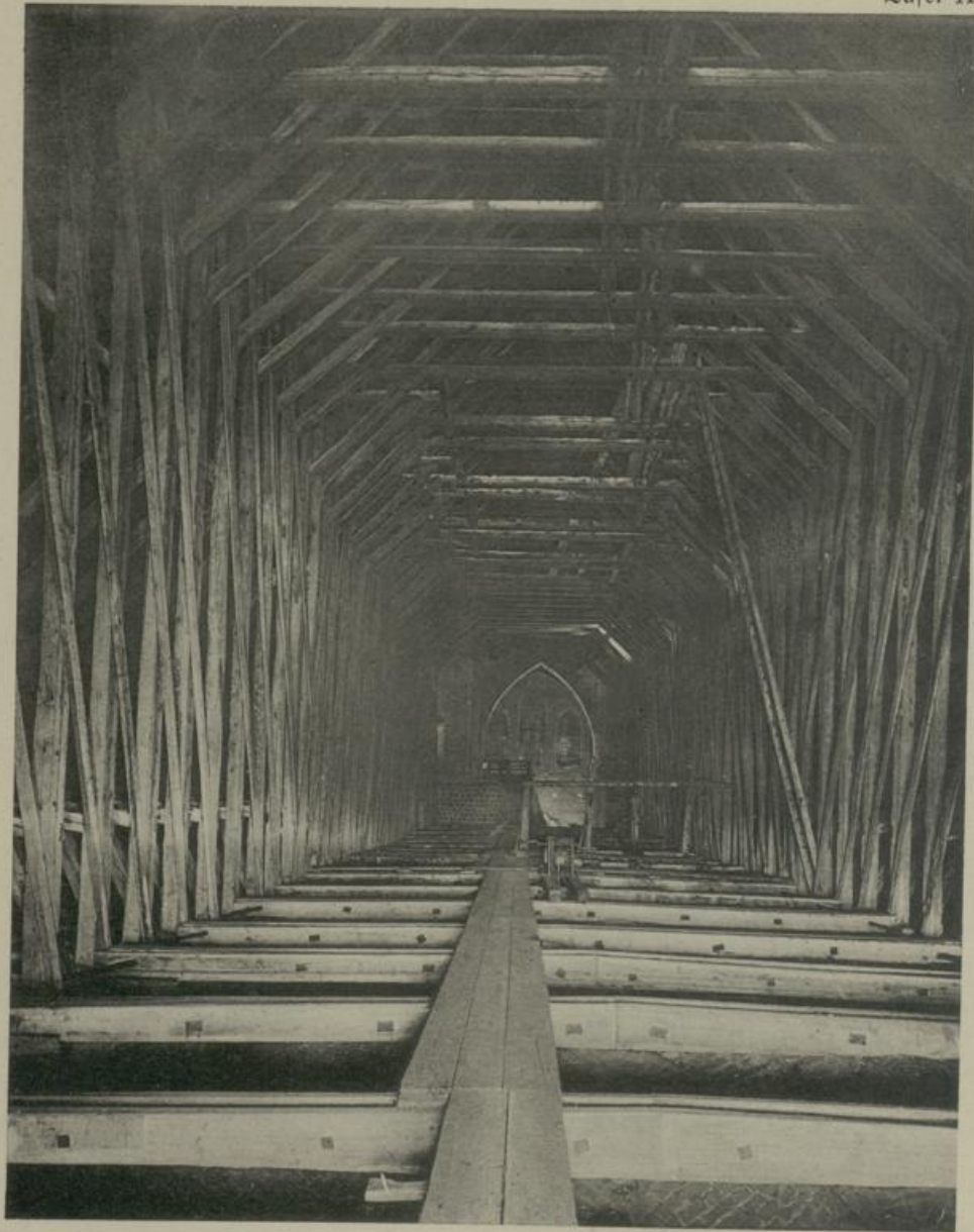
Prenzlau. Marienkirche. Dachstuhl, gegen Westen gesehen.
