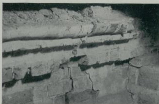
230. Bernau. Marienkirche. Hauptgesims der einstigen Ostfront der Nordschiffe
