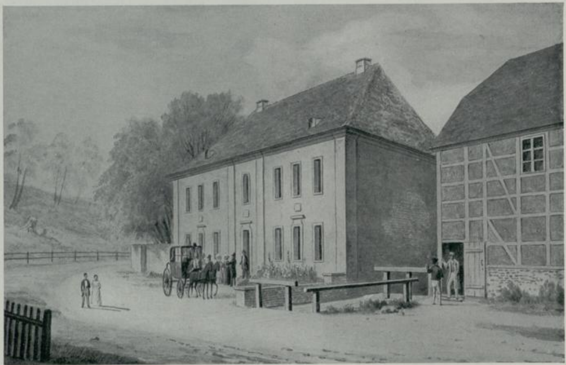
361. Schloß Dammsmühle. Das als Puzbau umgestaltete Wohnhaus (Ansicht von 1841)
