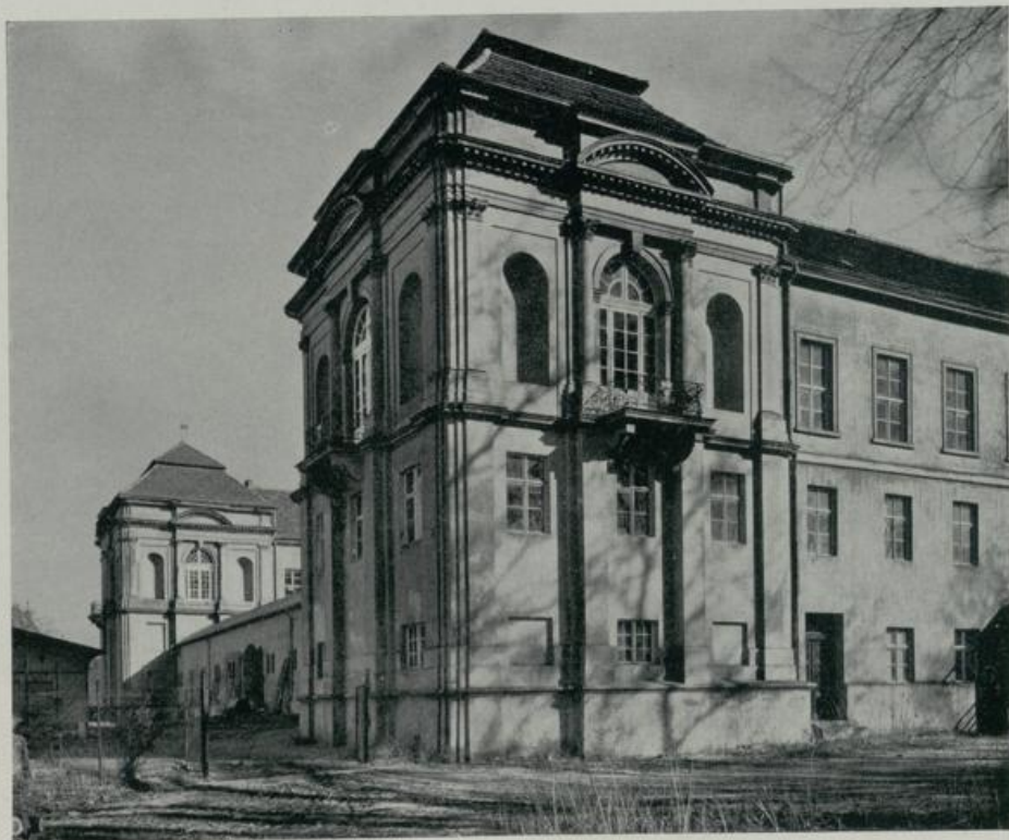
492. Dranienburg. Schloß. Nördliche Kopfbauten (vor der Erneuerung von 1938)
