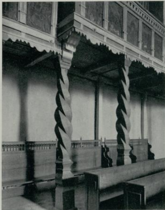
300. Bernau. Marienkirche. Emporenstützen
