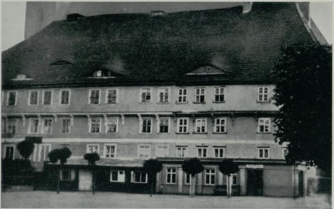
325. Bernau. Häusergruppe auf der Nordseite des Marktes (nicht mehr erhalten)
