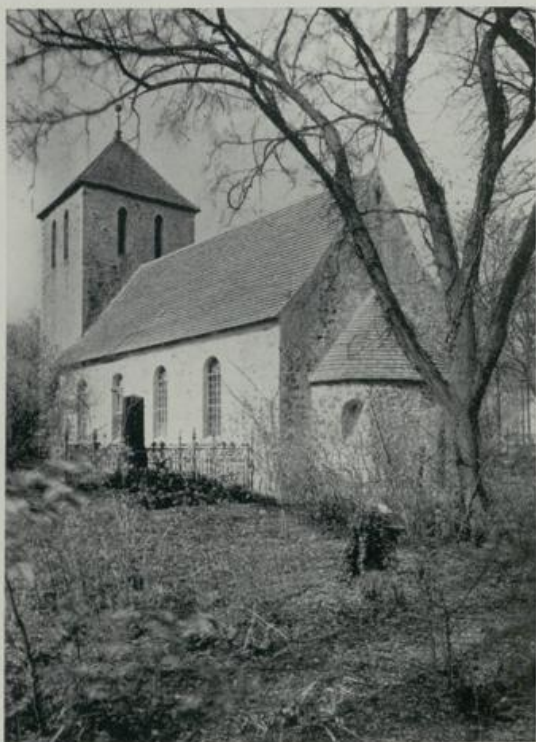
654. Werder. Kirche von Südosten
