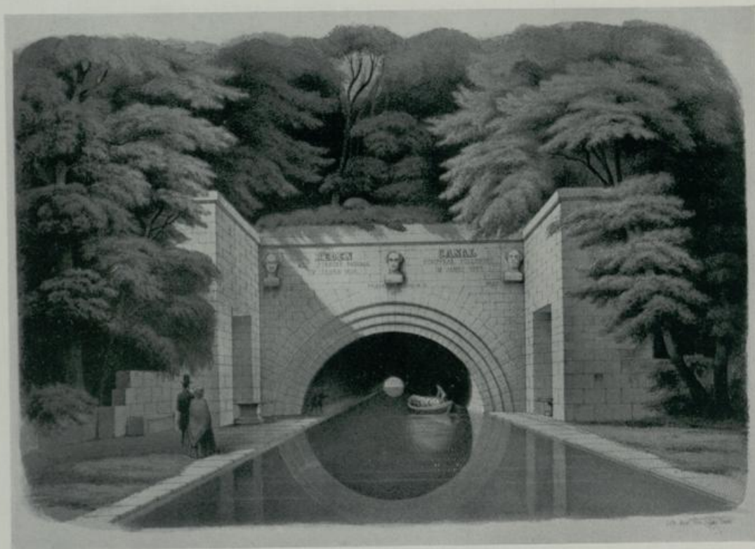
535. Rüdersdorf, Portal des Redenkanals (1827 vollendet)
