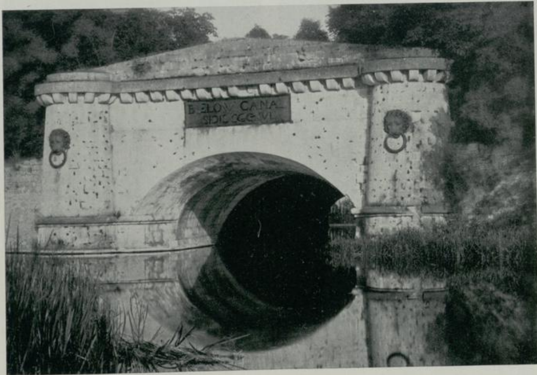
538. Müdersdorf. Portal des Bülow-Kanals (1816)
