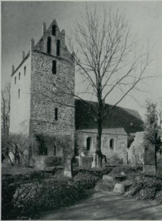
342. Börnick. Kirche von Südwesten
