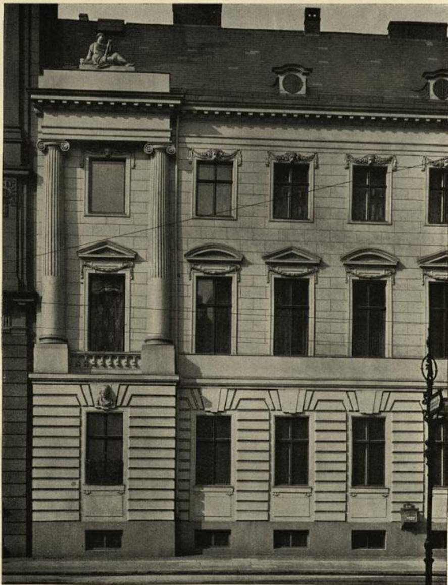
Mauerstraße 36. Rahels Wohnung im I. Stock. Naturaufnahme.
