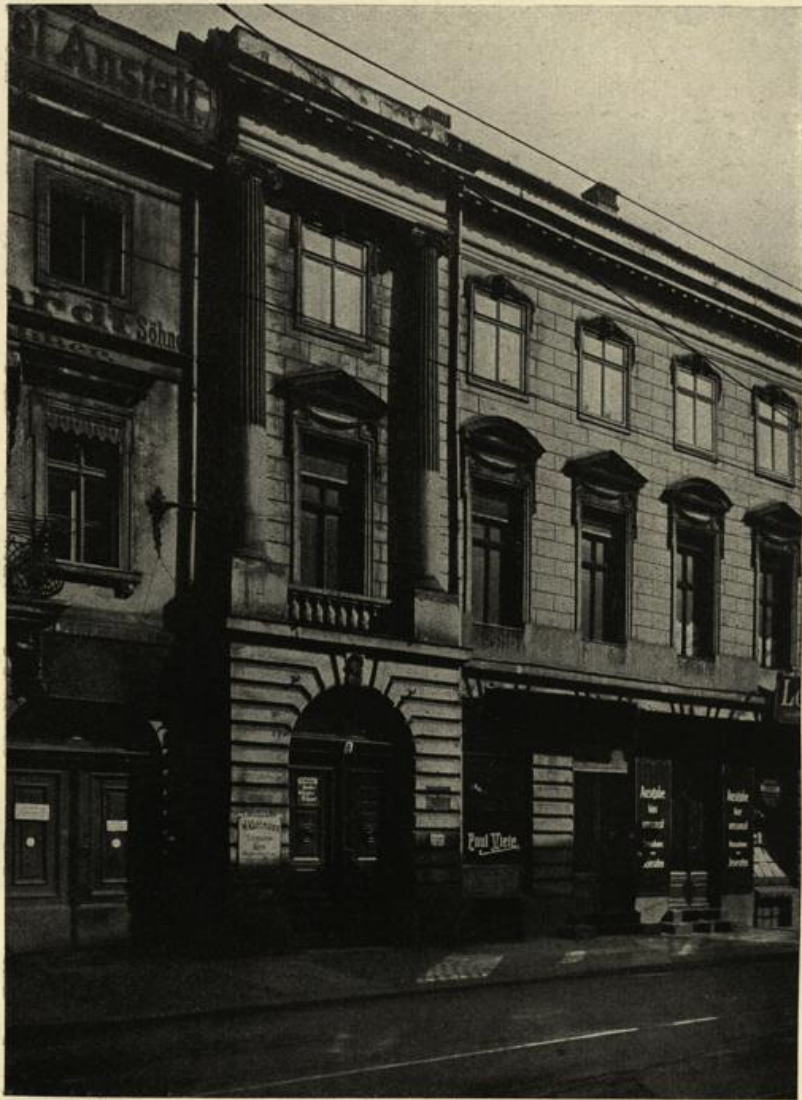
Neue Schönhauser Straße 5. Naturaufnahme.
