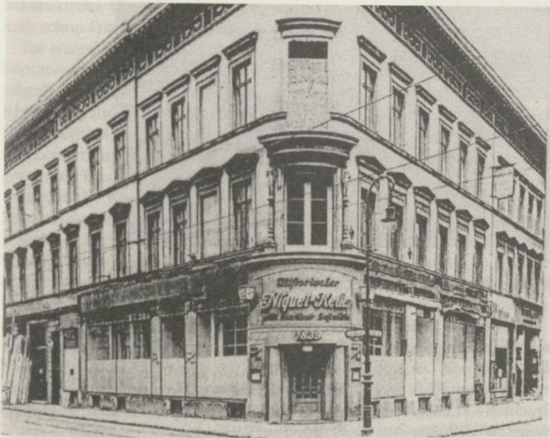
Abb. 2: Eingang zum Niquet-Keller an der Ecke Jägerstraße / Oberwallstraße.
