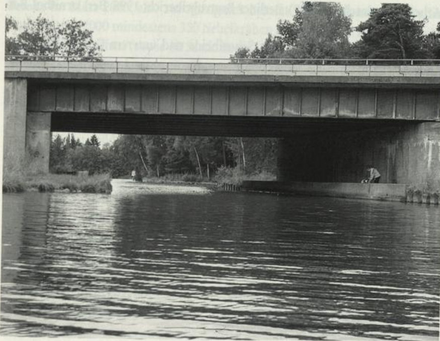
Abb. 1: Rauchschwalben-Brutplatz unter der Autobahnbrücke bei Groß Köris. 28.6.2000. Foto: T. Noah. Fig. 1: The Swallow breeding site under the bridge near Groß Köris.
