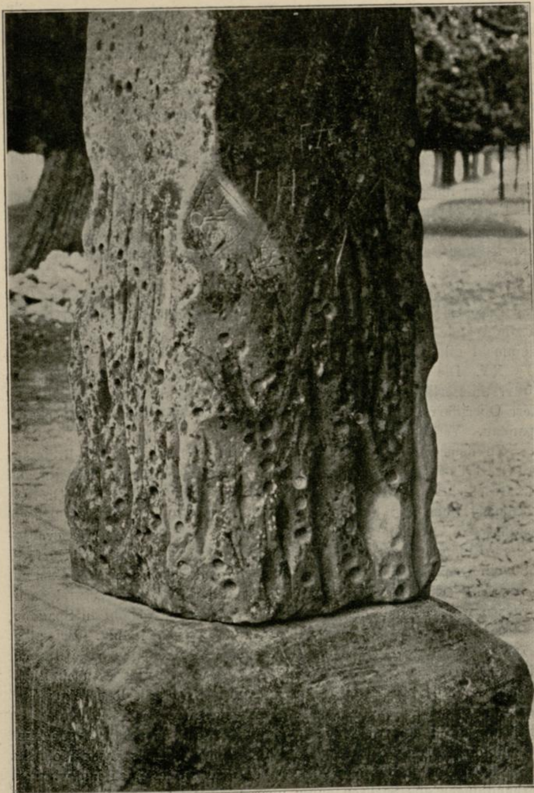
Mittelteil der alten Postsäule in Buchholz b. Treuenbrietzen. Zeigt neben Näpfen, die vom Einsetzen der Wanderstöcke herrühren dürften, noch Längsrillen, Zunftzeichen und Querzinken.
