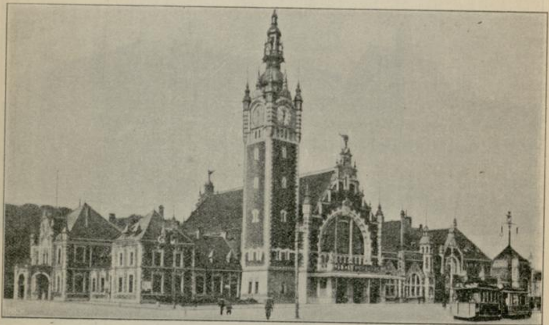
Abb. 9. Hauptbahnhof in Danzig.
