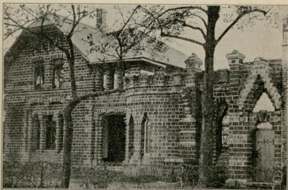
Abb. 11. Wohnhaus in Paderborn (Verfahren Würdehoff).
