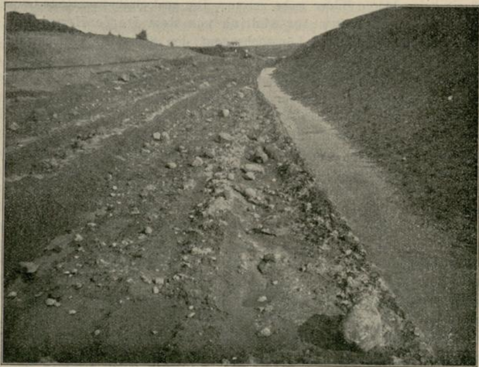
Abb. 5. Einschnitt für die oberste Schleuse bei Liepe. — Photograph H. König.
