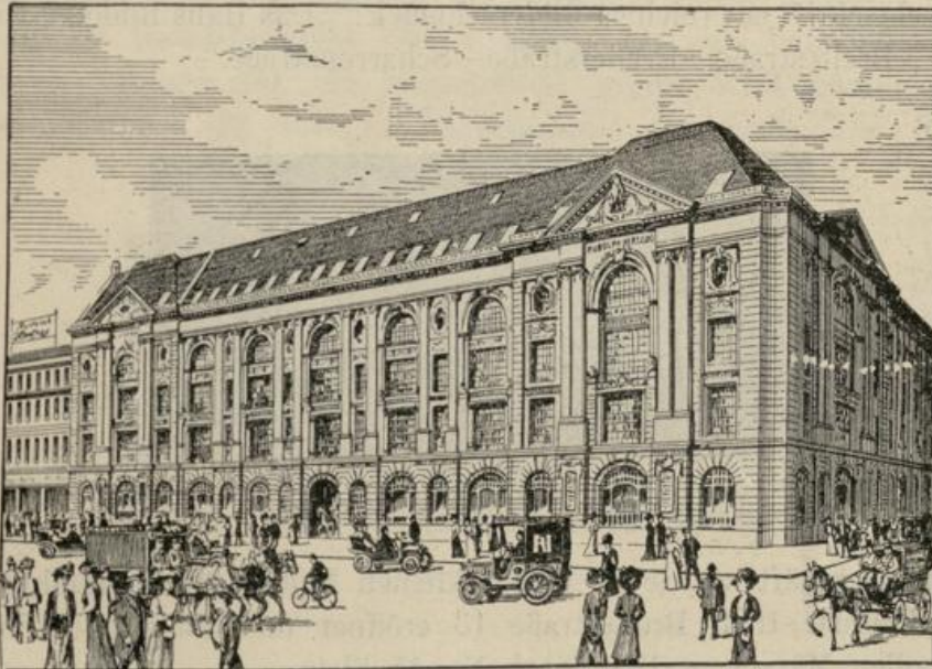
Abb. 3. Rudolph Hertzogscher Neubau Brüderstr., Ecke Scharrenstr. um 1910.
