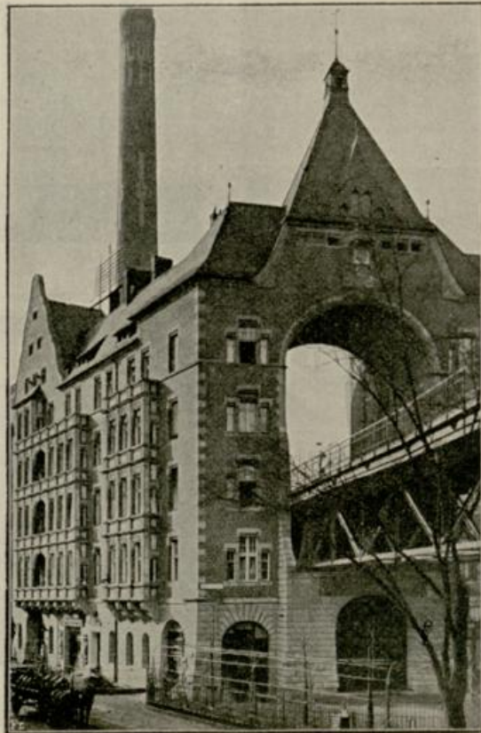
Fig. 18. Das durchschlitzte Haus der Hoch- und Untergrundbahn zu Berlin.
