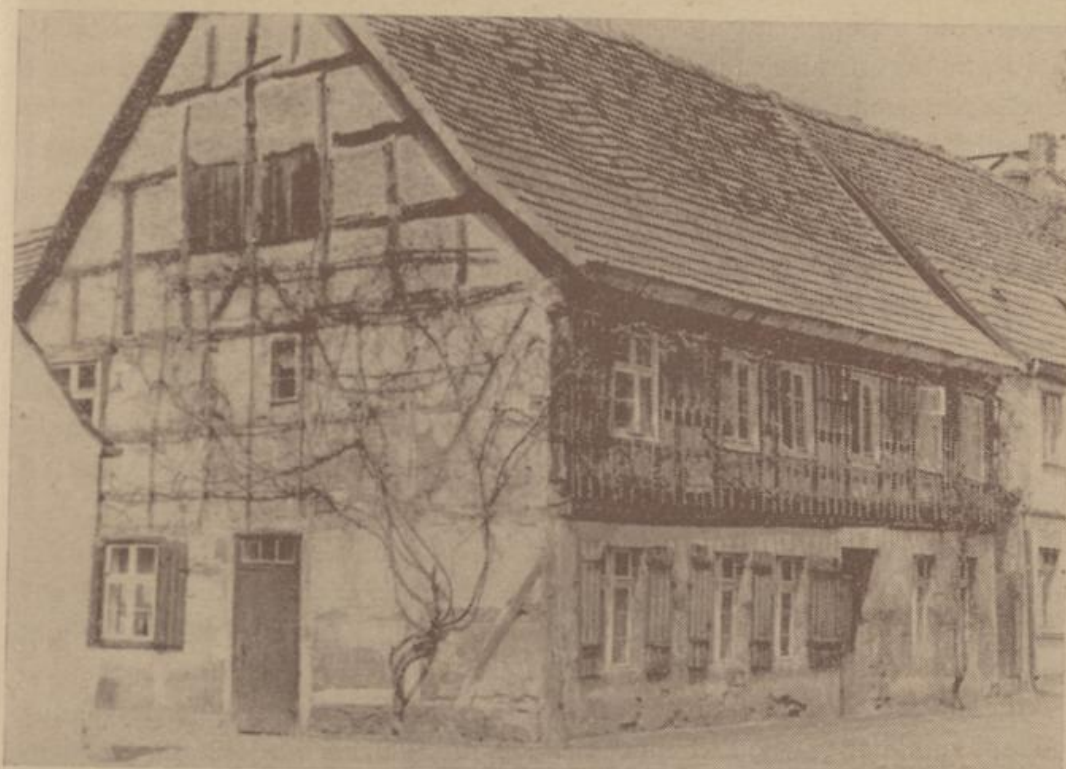
Altes Siechenheim in der Uferstraße
