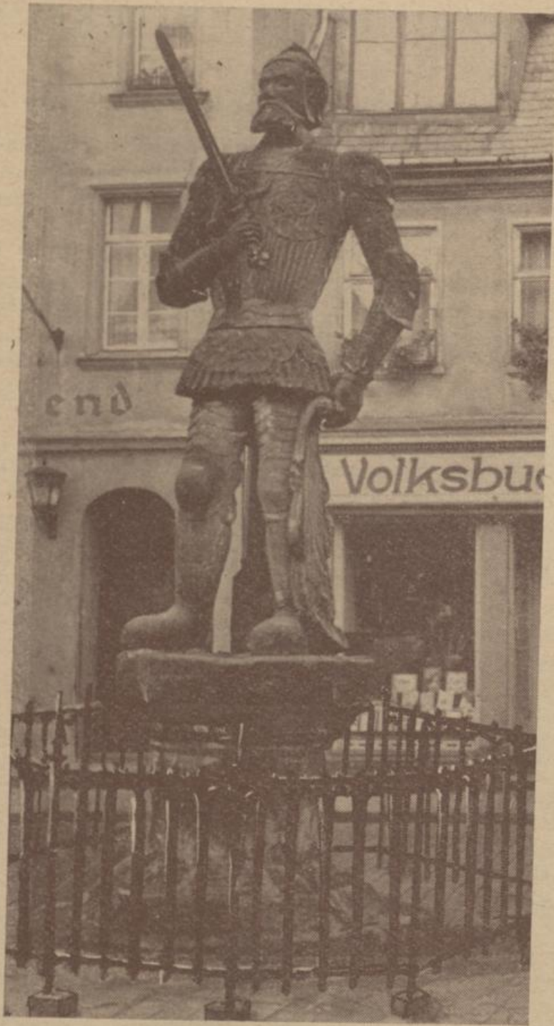
Ansicht nach der Fertigstellung
