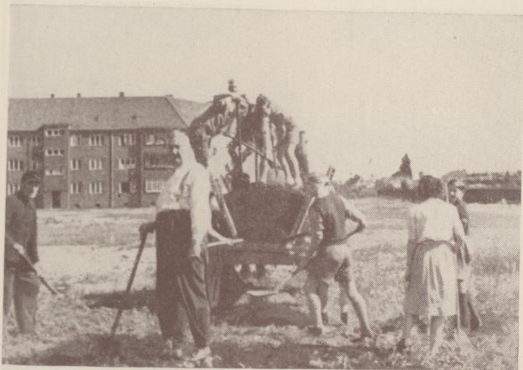
Aufbauhelfer bei der Arbeit auf dem Heisterbusch
