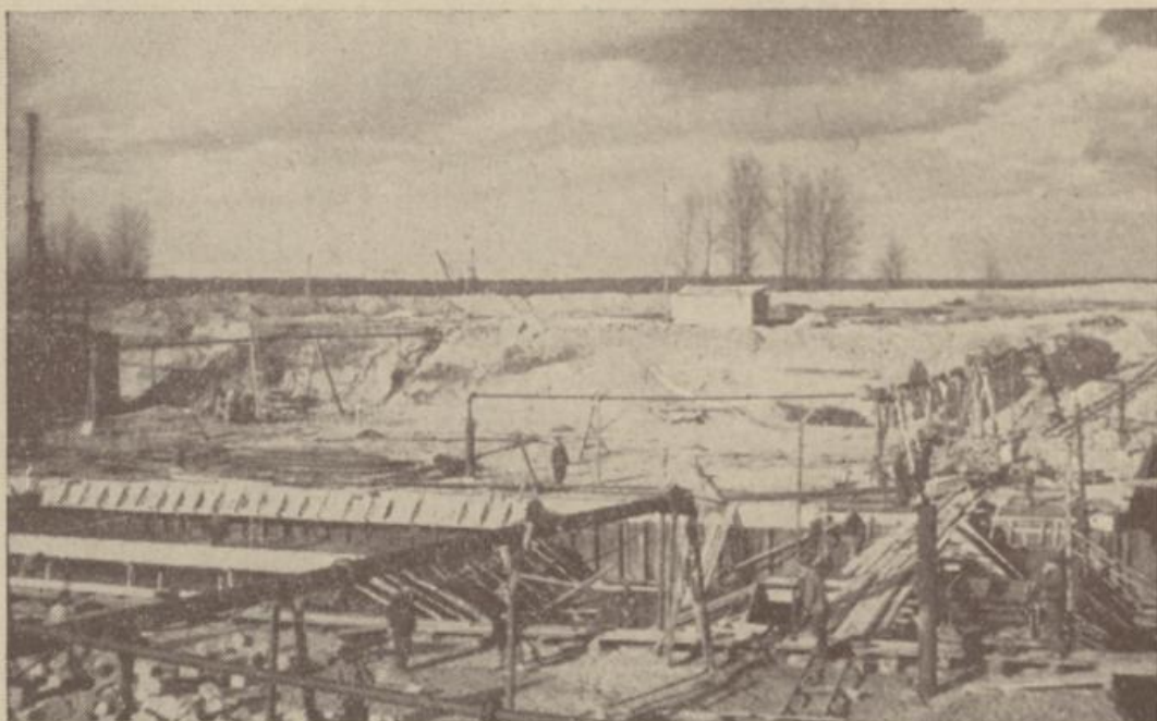
Betonieren der Fundamente Wehr Neuwerben
