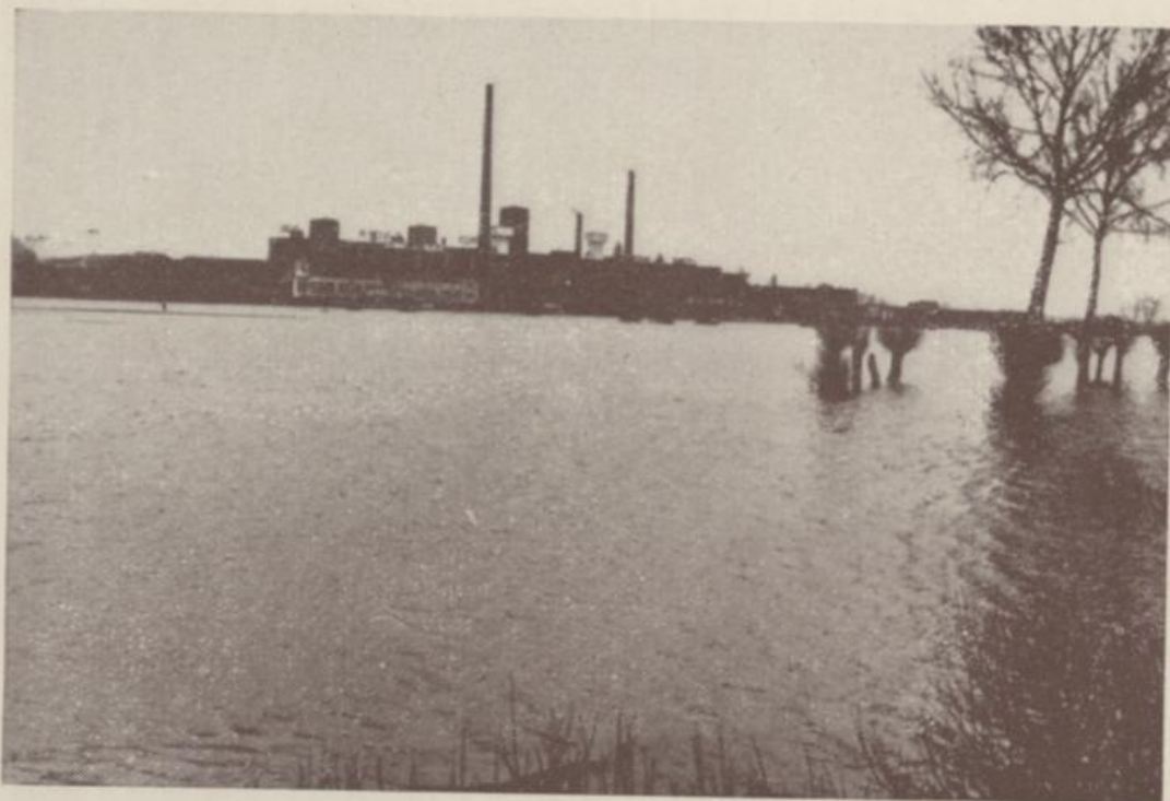
Hochwasser am Singer-Werk AG. (heute VEB Nähmaschinenwerk) vor 1939
