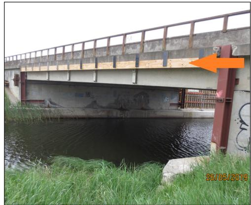
**Abb. 13:** An einer Autobahnbrücke angebrachtes Schutzbrett.
