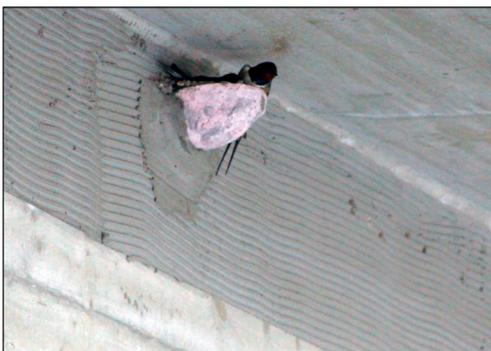
**Abb. 16:** Manuell angebrachter Rauputzstreifen am oberen Rand der Stahlbetonträger.
