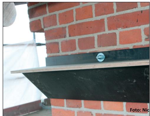
**Abb. 11:** Stabilisierung unter dem durchgehenden Kotbrett.
