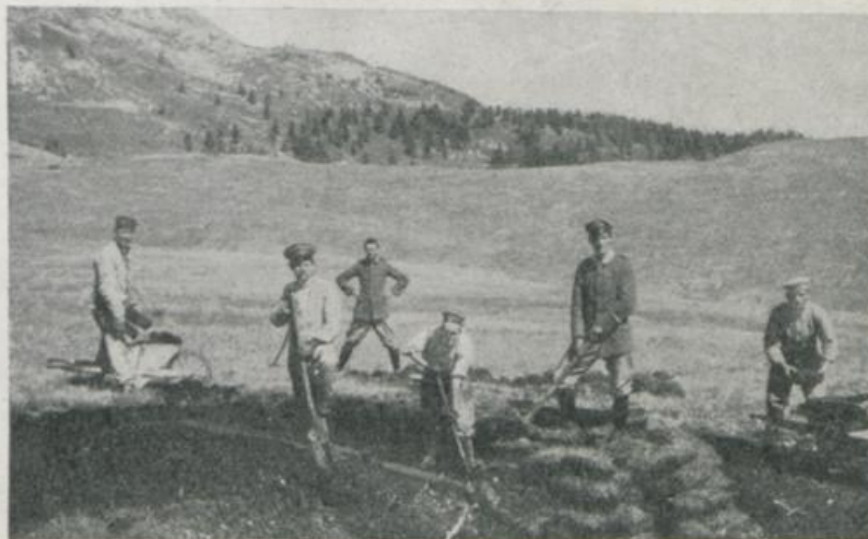
St. Moritz — Die ersten Spatenstiche.
